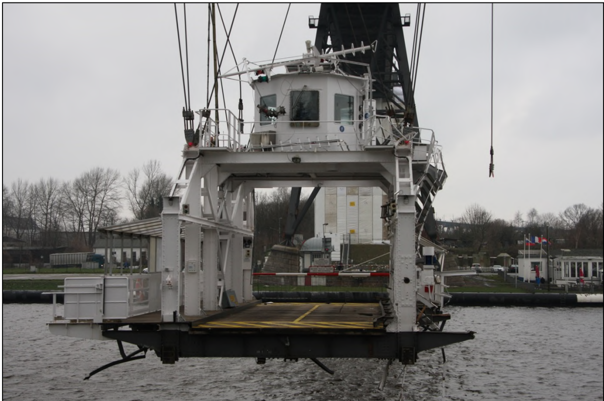
Die beschädigte Schwebefähre
