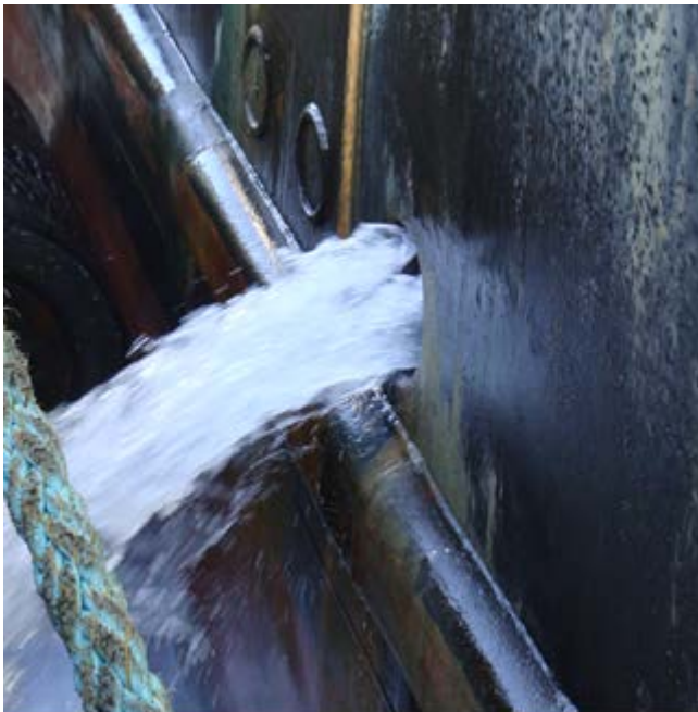
Der offene Kühlwasserablauf der JAN MARIA, Quelle BSU
