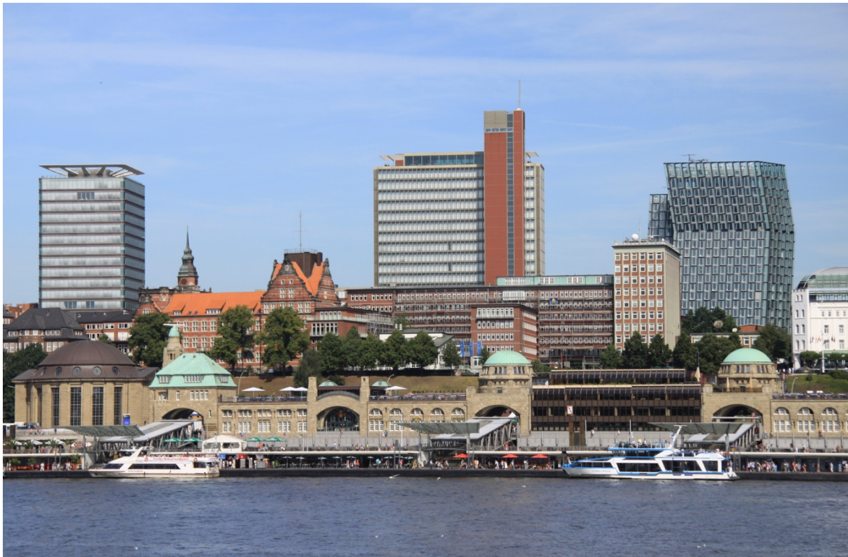
Der Dienstsitz der BSU in Hamburg im Gebäude des BSH. Im Vordergrund die Landungsbrücken, im Hintergrund rechts die sog. „tanzenden Türme“, links der Astraturm; Quelle Fotolia
