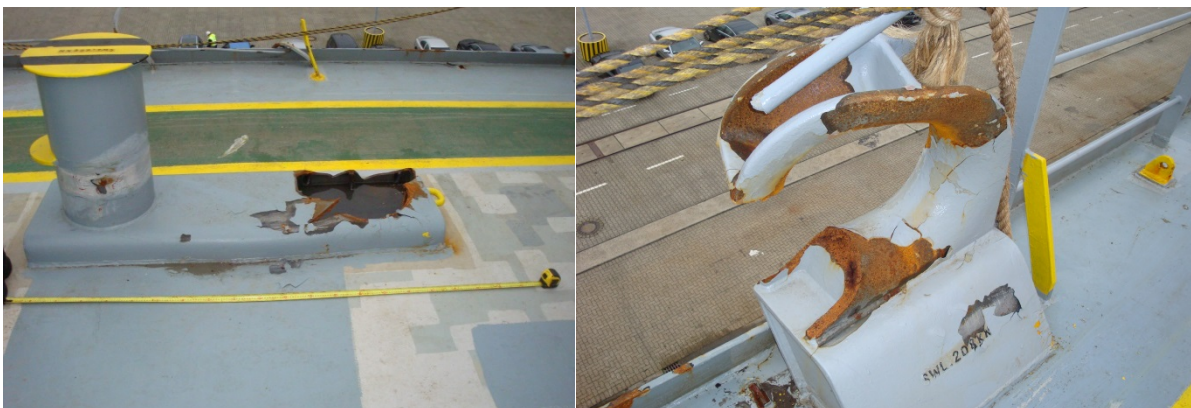
Herausgerissener Poller und zerstörte Klüse an Bord der GLORY AMSTERDAM, Quelle BSU
