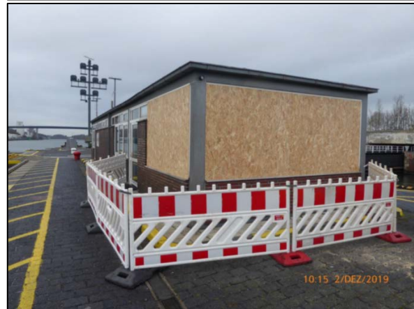
Abb. oben und links unten: Von der zurückschnellenden Leine verursachte Schäden (Quelle: WSP)
