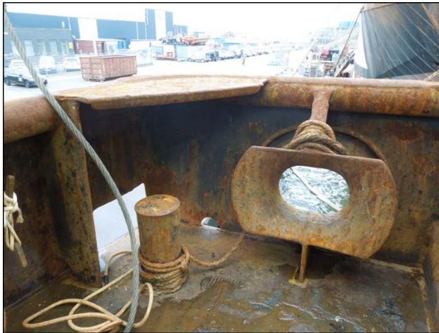
Abbildung 5: Absturzzort des Fischers am Heck 6
