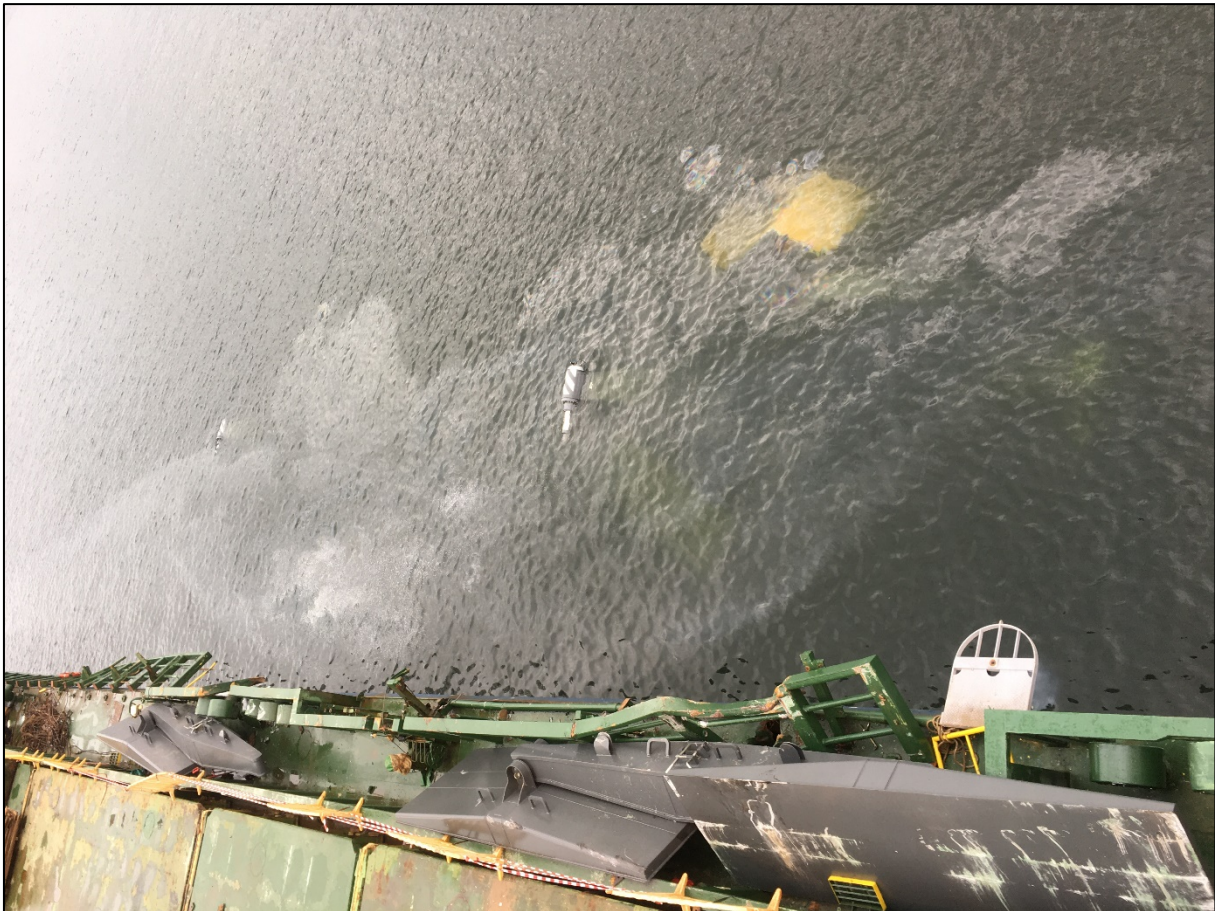
Abbildung 10: Die Kräne sind versunken, auslaufendes Öl und Schäden an Bord sind sichtbar. 12
