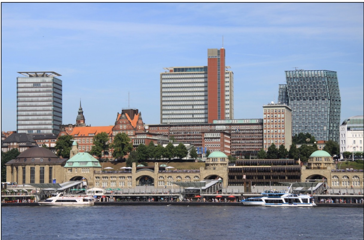
Abbildung 1: Der Dienstsitz der BSU in Hamburg im Gebäude des BSH 1 . Im Vordergrund die Landungsbrücken, im Hintergrund rechts die sog. „tanzenden Türme“, links der Astraturm.
