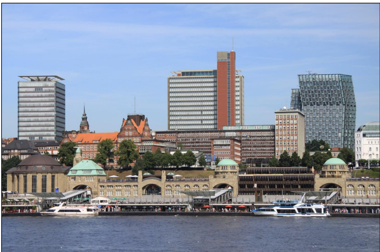
Abbildung 1: Der Dienstsitz der BSU in Hamburg im Gebäude des BSH . Im Vordergrund die Landungsbrücken, im Hintergrund rechts die sog. „tanzenden Türme“, links der Astraturm. 2
