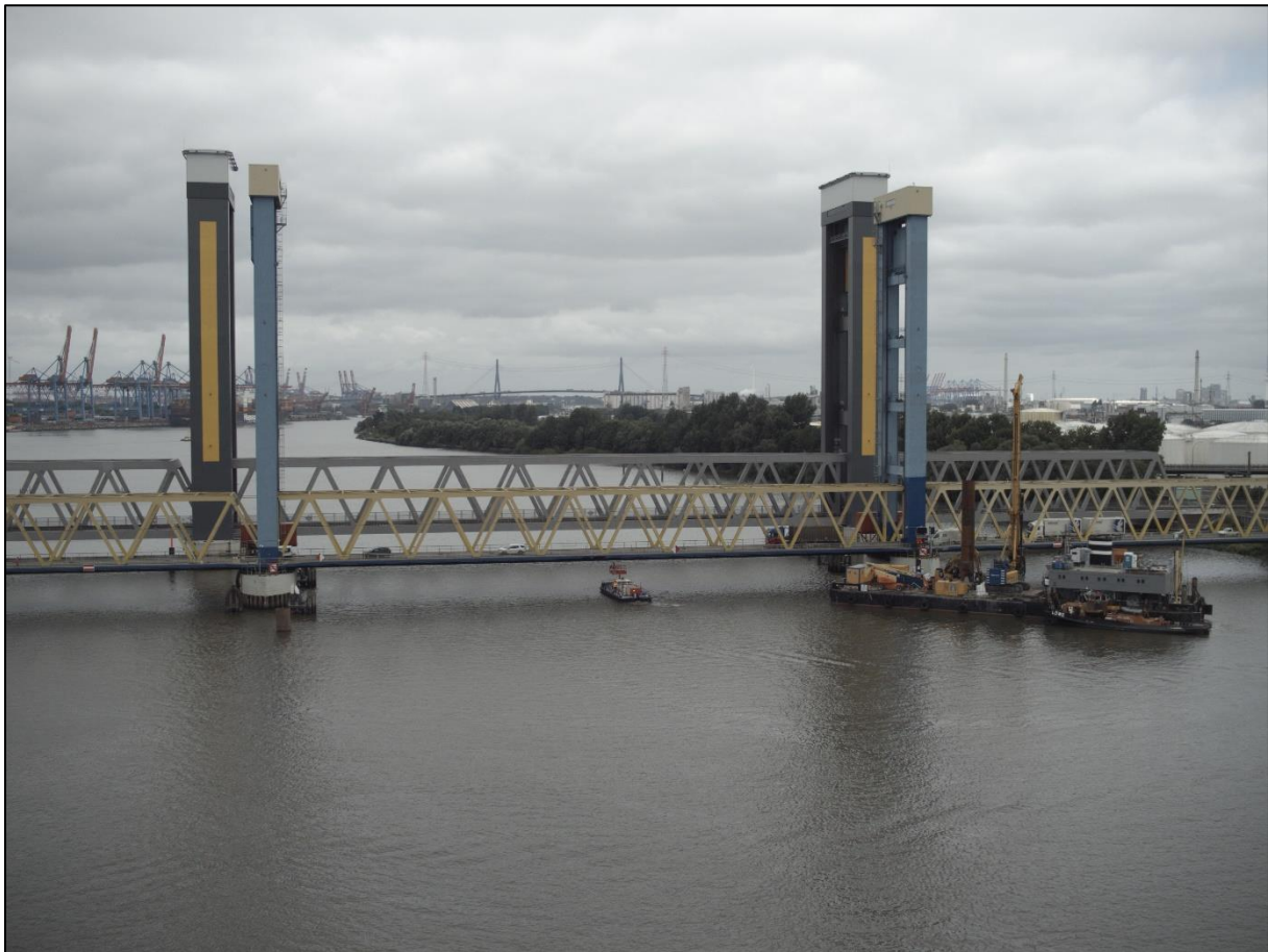
Abbildung 14: Die Kattwykbrücke, die auch zum Unfallzeitpunkt heruntergelassen war 24
