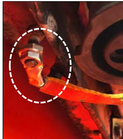
Abbildung 4: Erdungsanschluss nach Erneuerung
