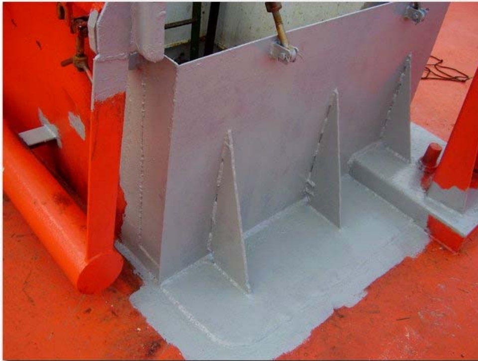
Abbildung: Repariertes und verstärktes Lukensüll auf der Back der CAP EGMONT
