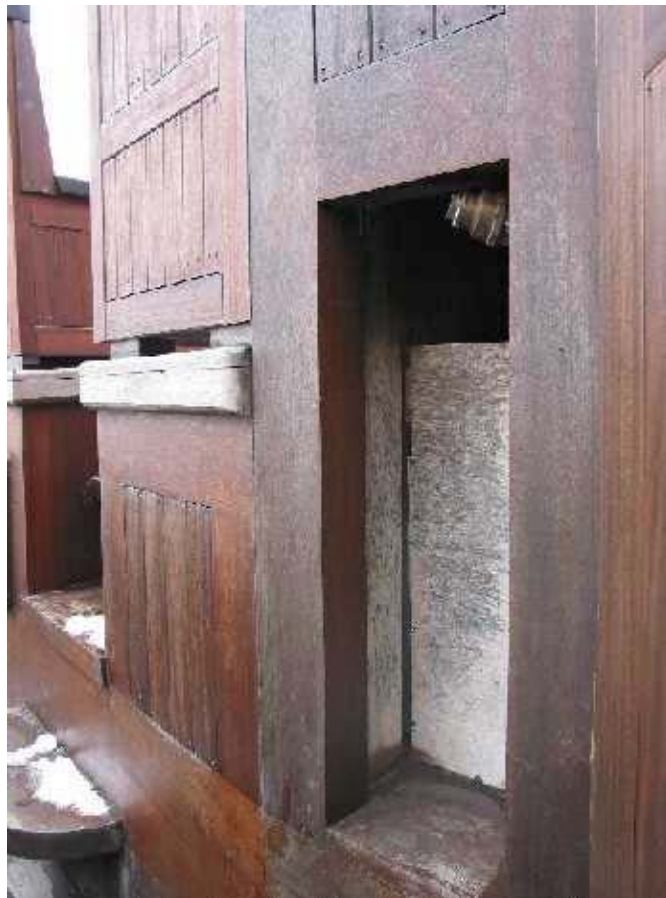
Abbildung 13, Belüftungsschacht Stb.-Seite (OUNV4P)
