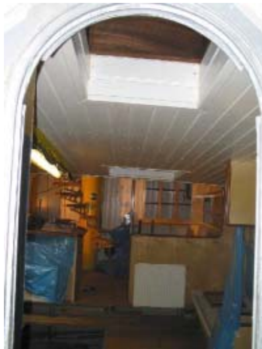
Abbildung 11, Schotttür und Skylight vorne
