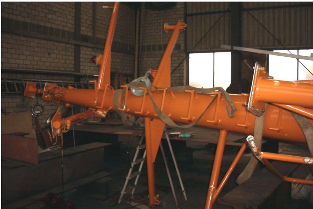
Abbildung 10: Schäden am Radarmast
