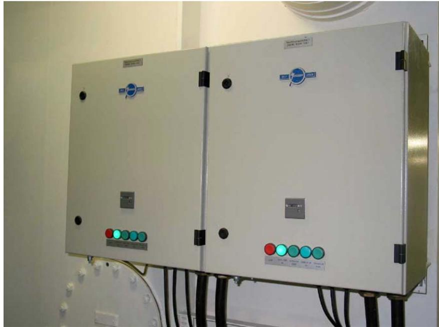
Abbildung 13: Schaltschrank Lüfter Maschinenraum
