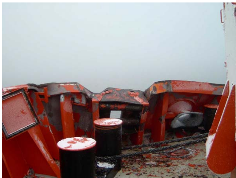
Abbildung 10: TMS EBRO Klüfte in der Verschanzung
