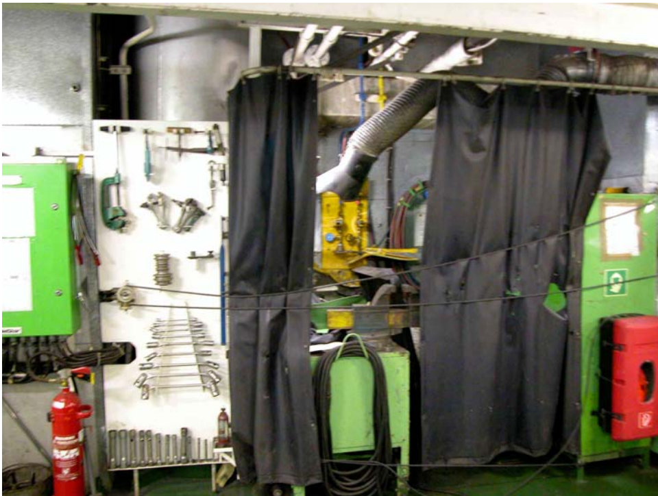
Abbildung 5: durch Vorhang abgetrennter Schweißerarbeitsplatz (Ansicht 2)
