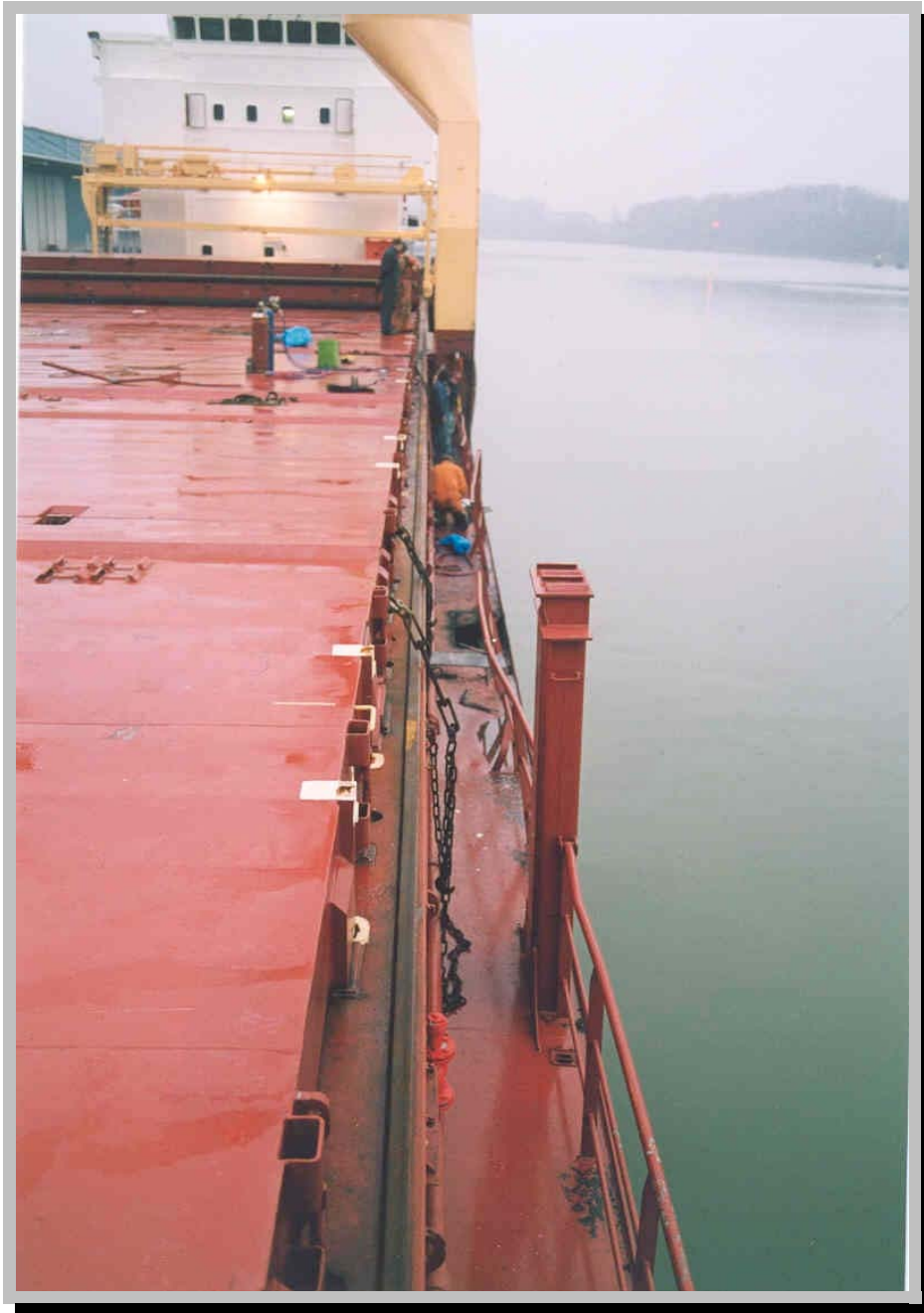
Abbildung 5: Schadensbild MS BBC SWEDEN
