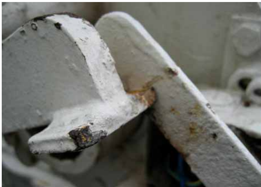
Abbildung 19: Endschalterhebel hinter dem Sicherheitsriegel
