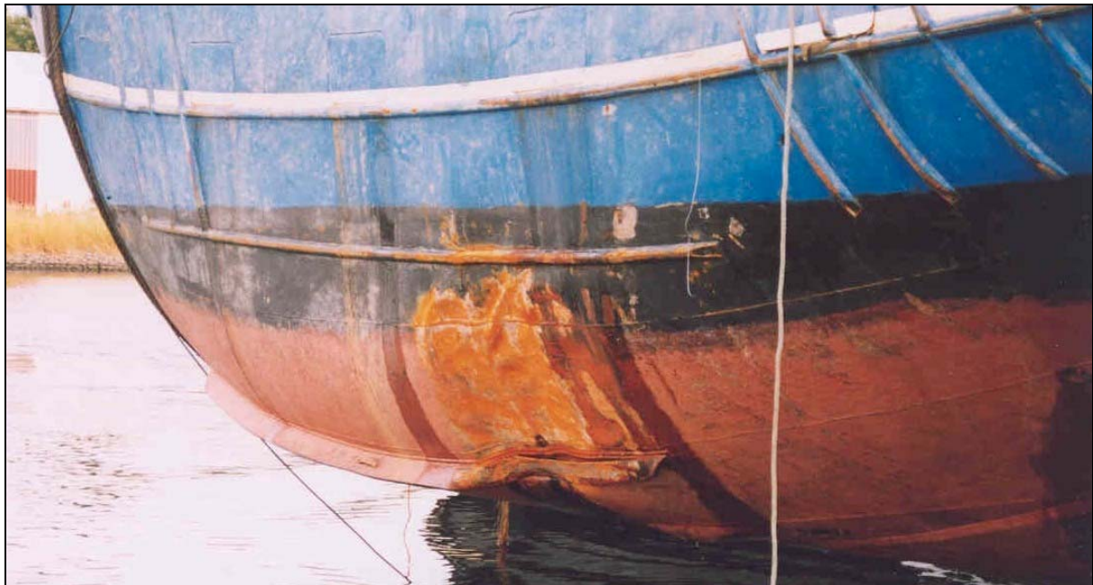
Abbildung 14: Schadensbild 4 – FK GRETJE GRE8
