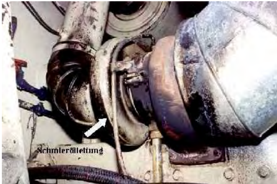
Abbildung 14: ATL abgenommene Isolierung
