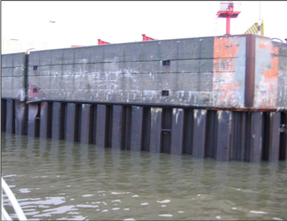
Abbildung 3: beschädigte Kaianlage
