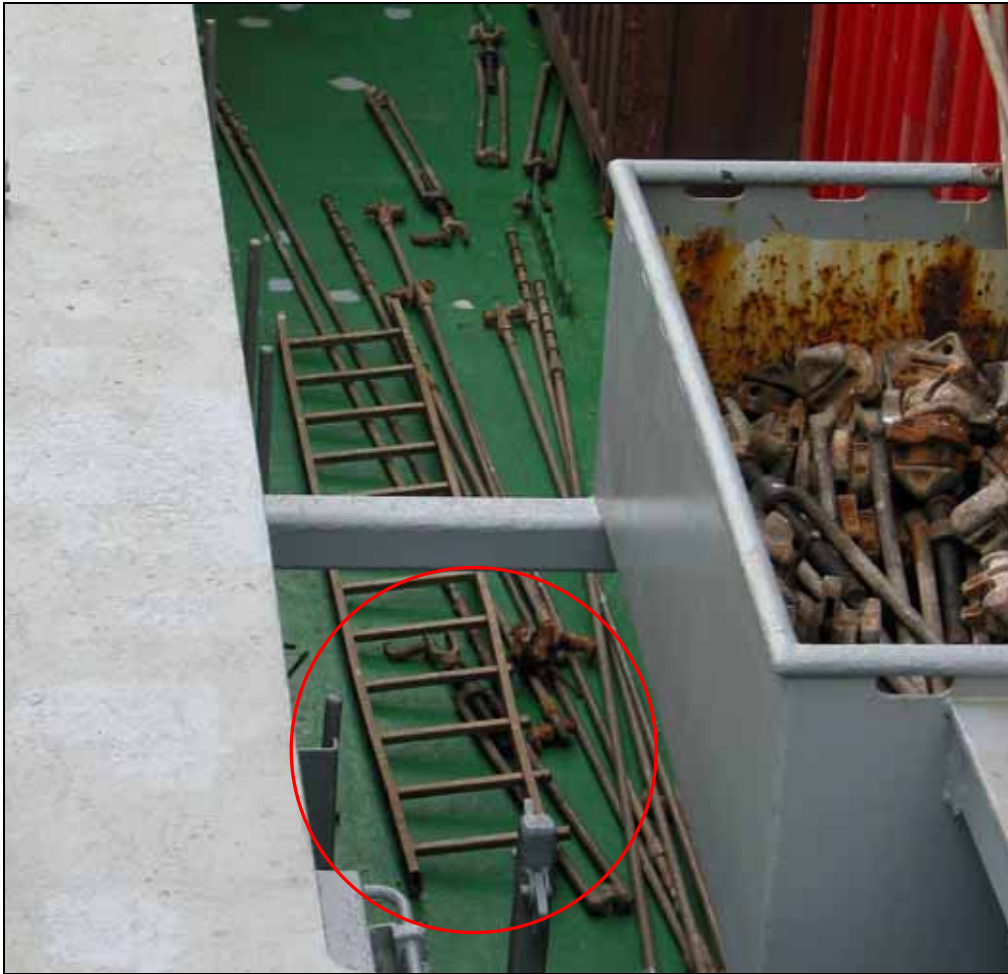
Abbildung 15: lose Sprossen
