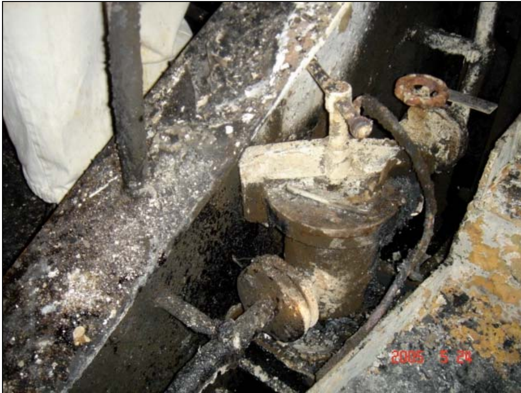
Abbildung 7: Dieselölfilter im Notsystem
