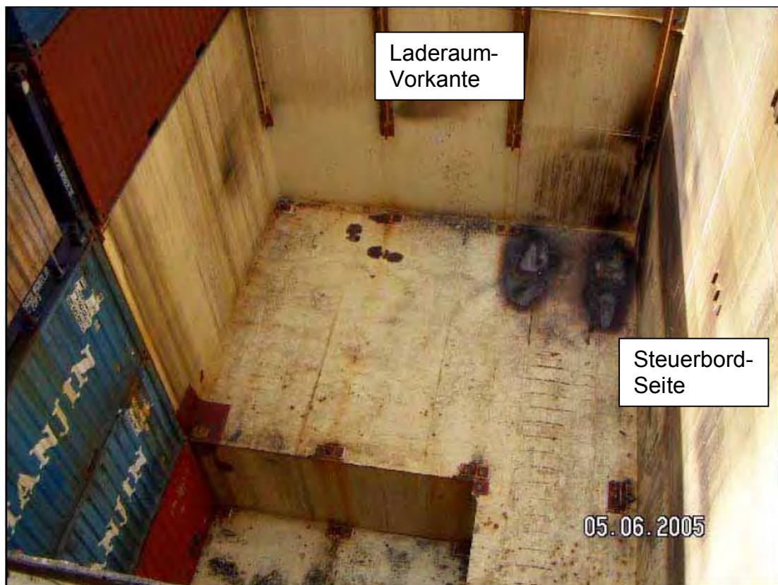
Abbildung 7: Laderaum 6 Stb. - Sicht von oben
