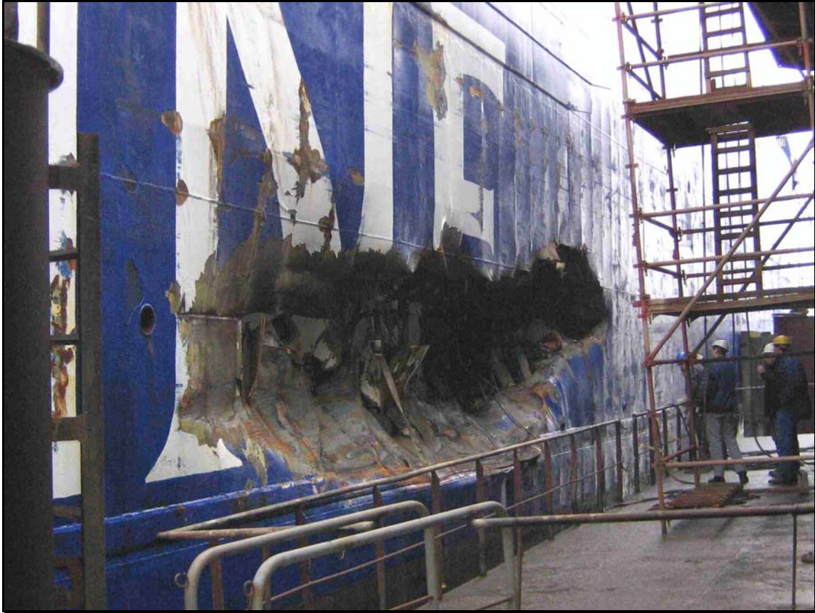
Abbildung 9: TOR DANIA – Schadensbild 4
