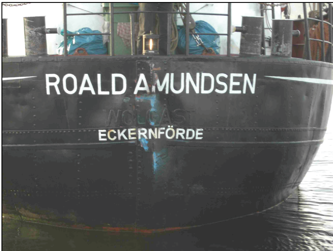
Abbildung 7: ROALD AMUNDSEN – Darstellung der Schäden
