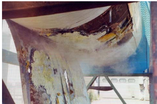
Abbildung 5: Abnehmen der Isolierung
