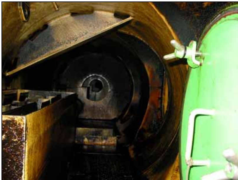
Abbildung 45: Blick von vorn in den achtern geschlossenen Spülluftkanal
