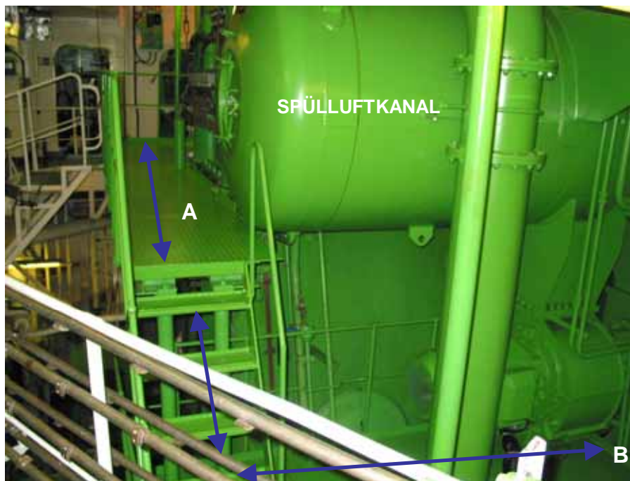
Abbildung 13: achterer Quergang (Spülluftkanalebene Achterkante und Steuerbordseite)
