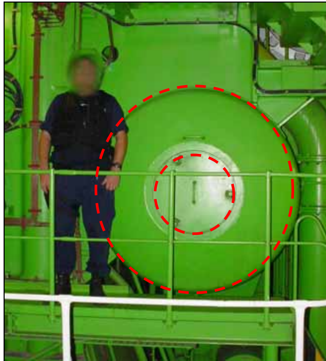
Abbildung 19: Spülluftkanal Achterkante mit geschlossener Einstiegsluke
