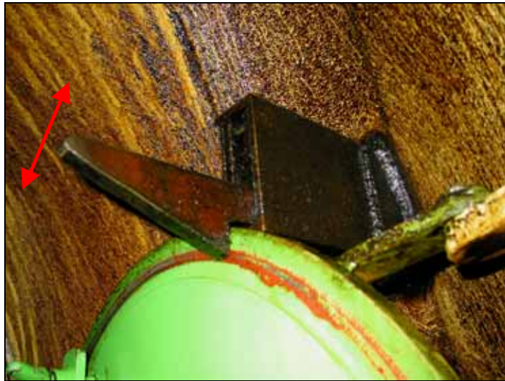
Abbildung 59: eingebauter Feststellhaken in Aktion
