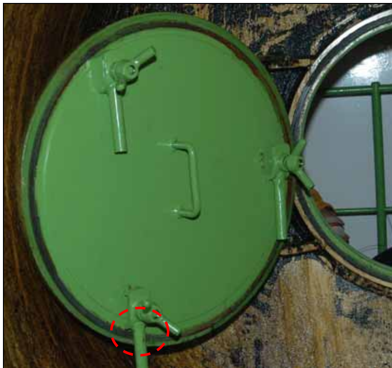
Abbildung 56: Blockadeposition der angeschweißten Rohrverlängerung
