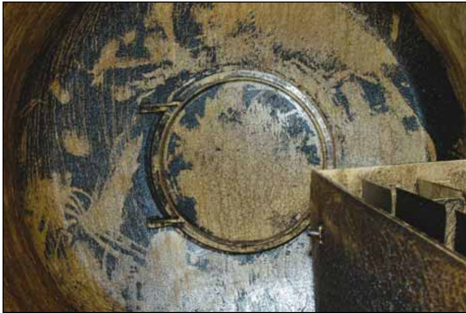
Abbildung 22: Mannlochdeckel Spülluftkanal Vorkante von innen 30
