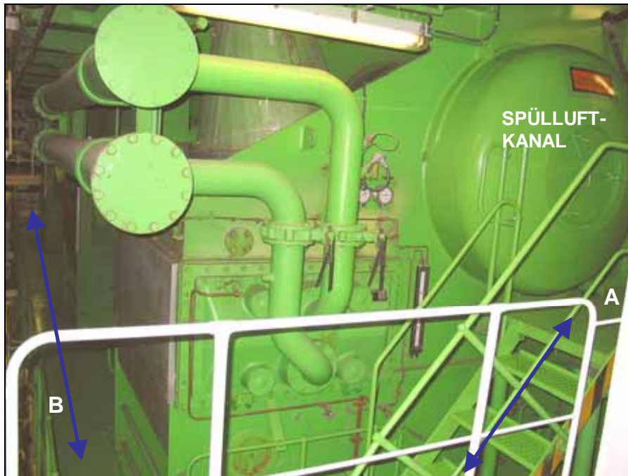
Abbildung 12: Spülluftkanalebene Vorkante und Steuerbordseite 22
