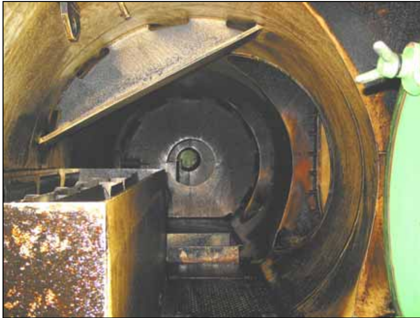
Abbildung 44: Blick von vorn in den achtern geöffneten Spülluftkanal
