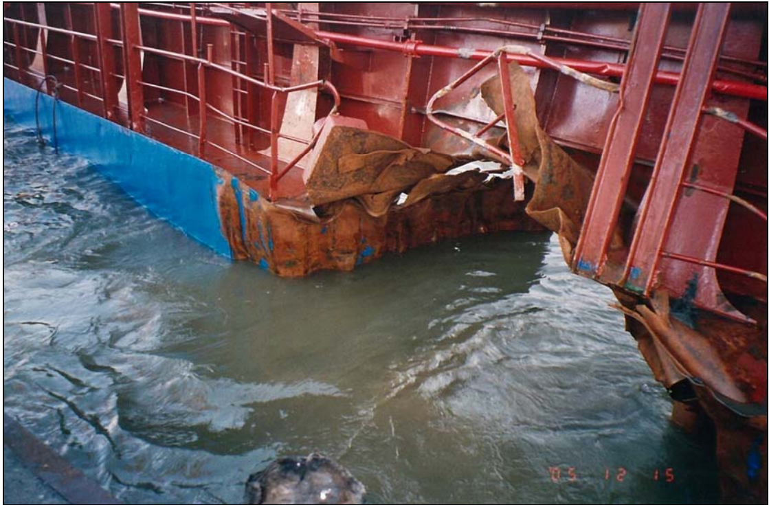
Abbildung 10: Beschädigung an der Stb.-Seite der Maritime Lady
