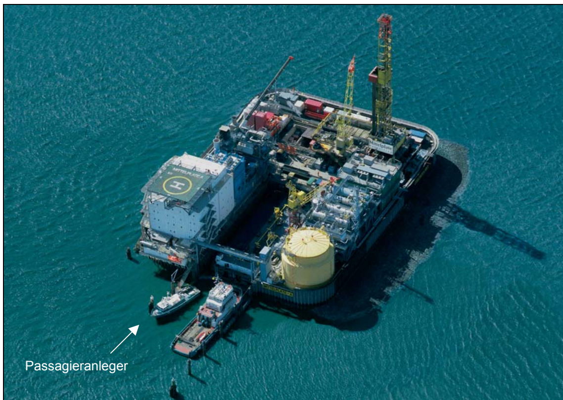
Abbildung 4: Bohr- und Förderinsel Mittelplate
