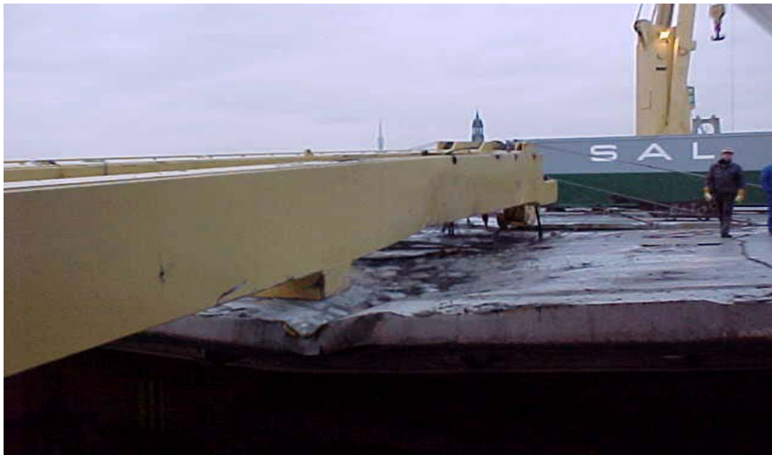
Abbildung 2: Schäden am Lukendeckel
