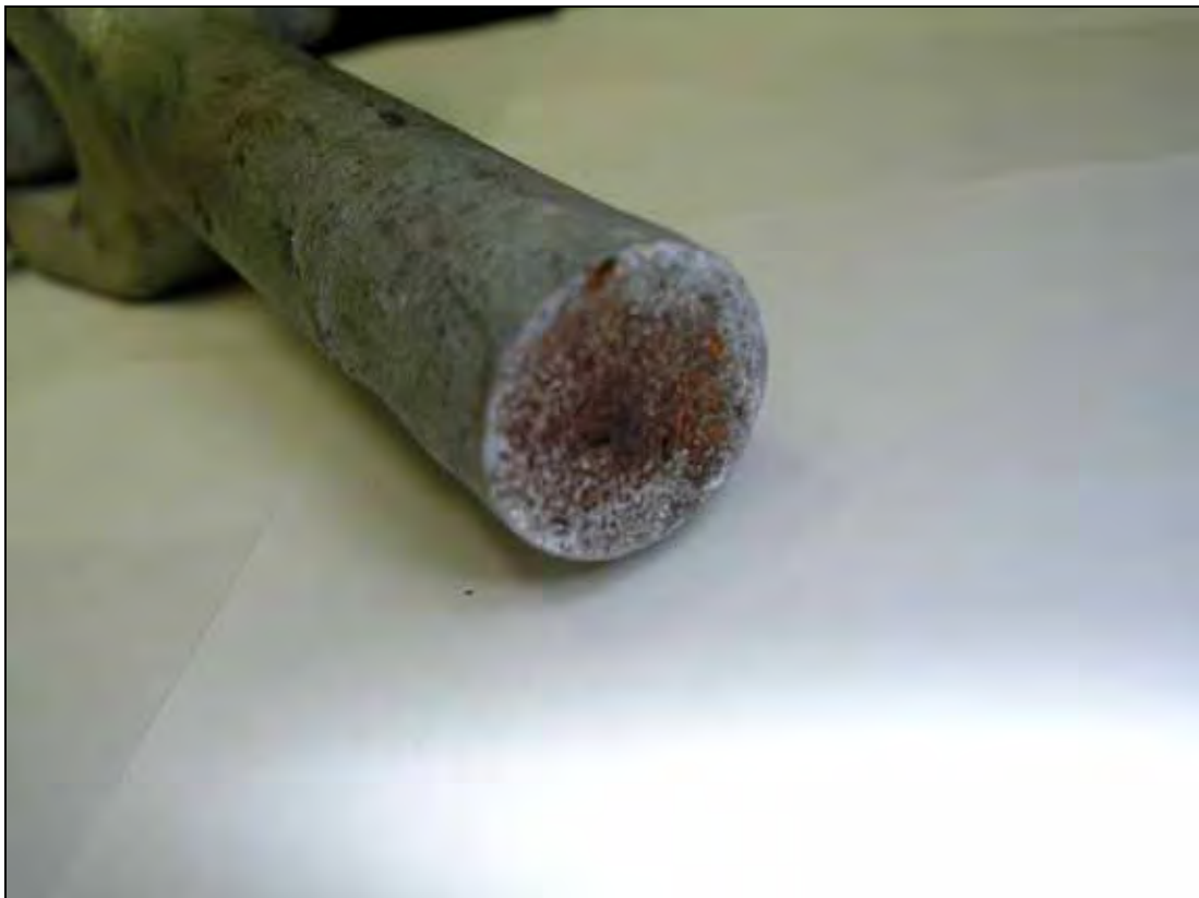
Abbildung 43: Korrodierte Bruchfläche der Laschstange
