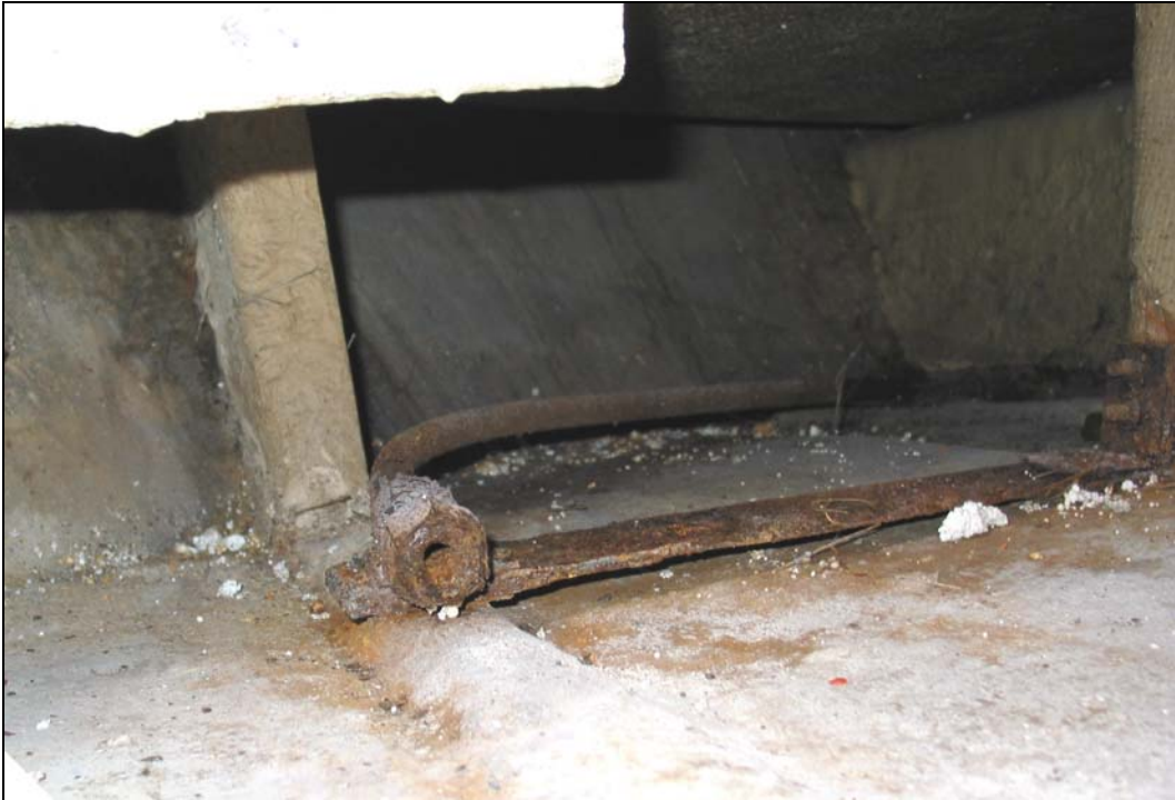
Abbildung 19: Führungsrohr des Stb.-Bediendrahtes am vorderen Austritt
