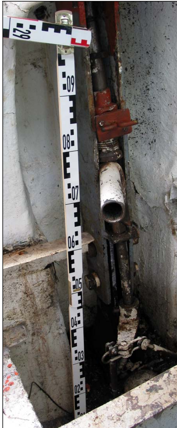
Abbildung 18: Auslösehebel in Auslöseposition
