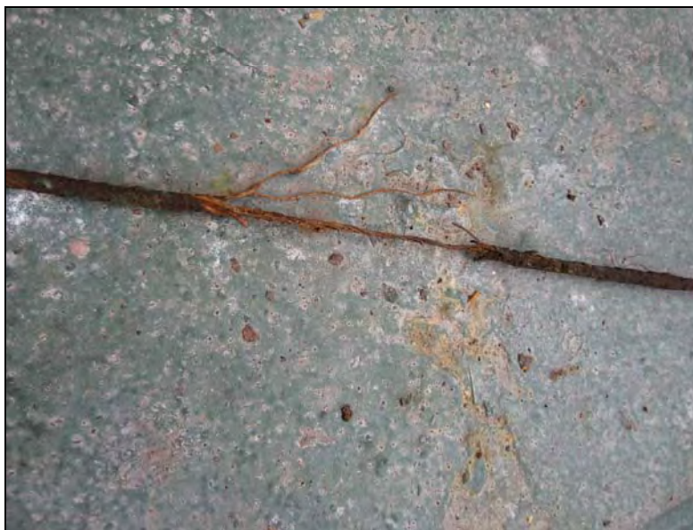
Abbildung 20: Beschädigter Draht der Fernbedienung
