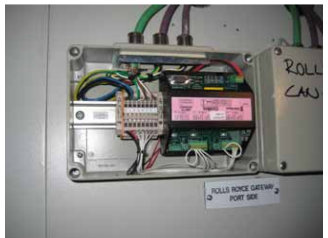
Bild 16: CAN-BUS Gehäuse (geöffnet)
