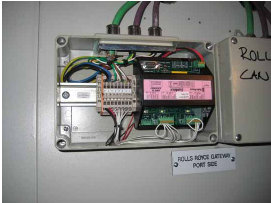
Abbildung 24: CAN-BUS-Gehäuse auf der FINNLADY, geöffnet
