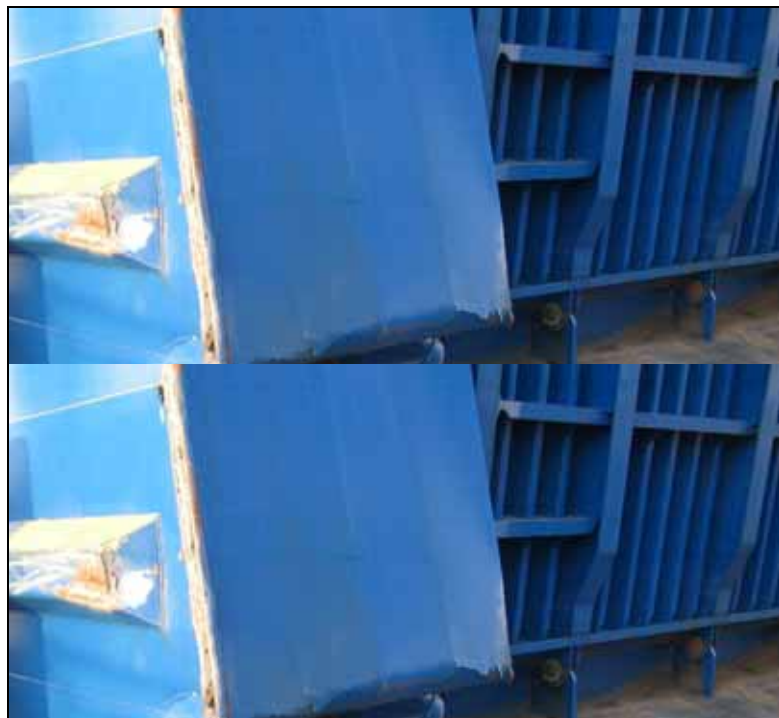
Abbildung 4: Beschädigter Kofferdamm auf der Backbordseite der FINNLADY
