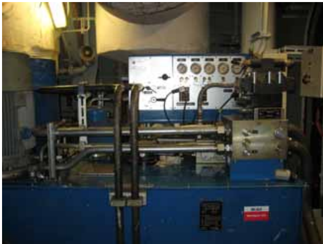
Bild 13: CPP Hydraulik-Pack mit Notbedienung
