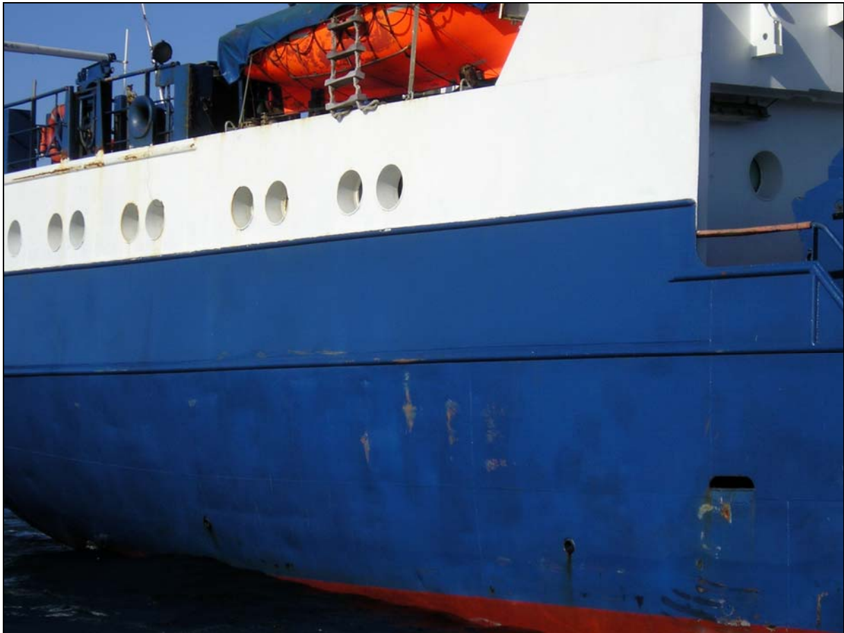
Abbildung 7: Schäden am Achterschiff der RABA
