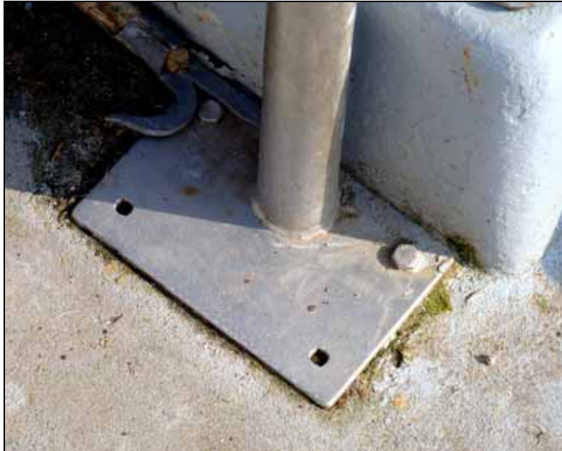
Abbildung 8: Grundplatte der Steuerbordmaststütze
