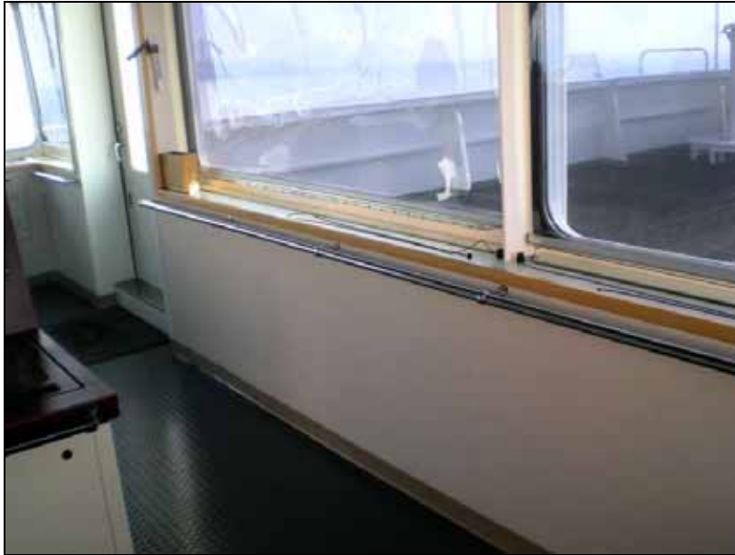
Abbildung 47: Handlauf Steuerbordseite Brücke
