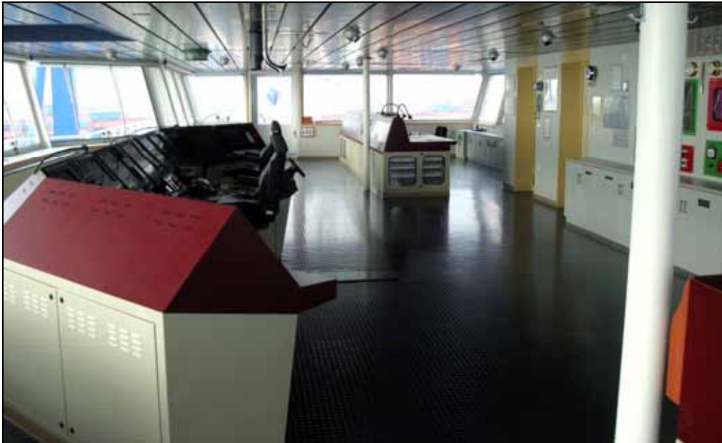
Abbildung 20: fehlende Handläufe Achterkante und Steuerbordseite Brücke
