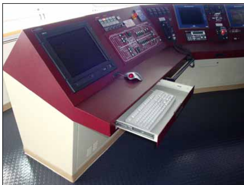
Abbildung 17: Unzureichende Ausstattung der Brückenkonsole mit Handläufen
