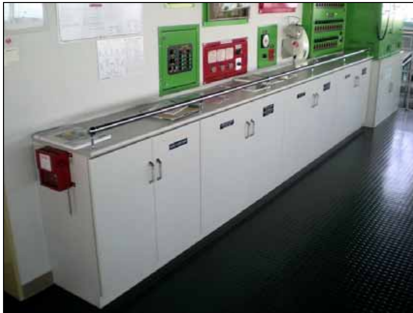
Abbildung 46: Handlauf Achterkante Brücke
