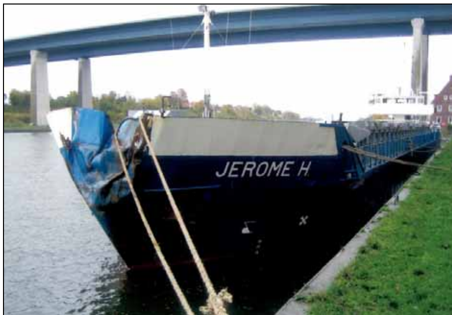
Abbildung 4: JEROME H Schaden am Steven
