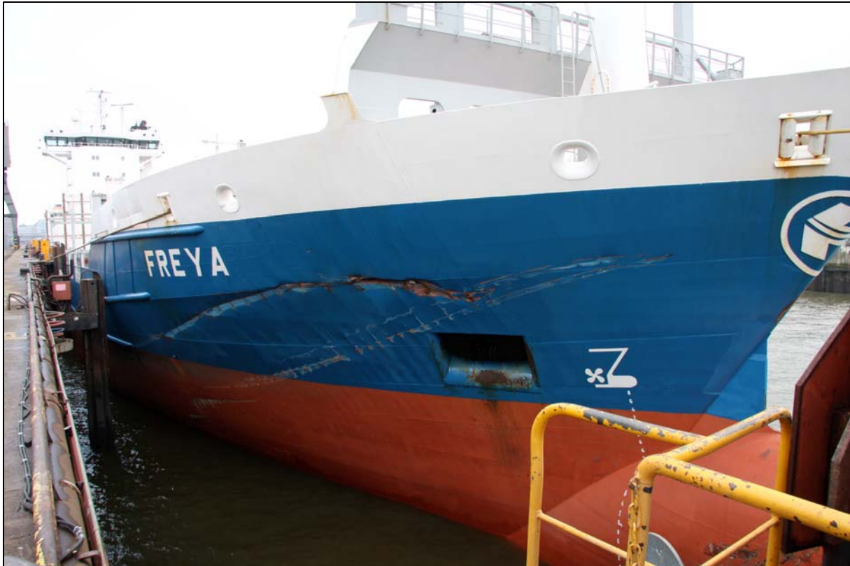
Abbildung 3: Beschädigte Steuerbordseite der FREYA
