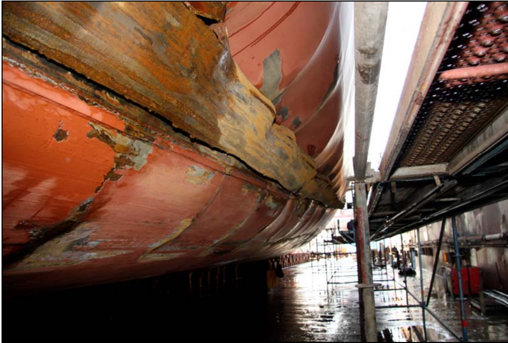
Abbildung 7: Beschädigtes Unterwasserschiff der FREYA
