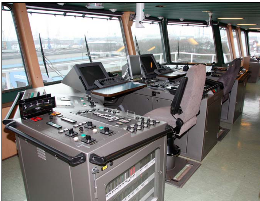
Abbildung 10: Brückenhaus der FREYA
