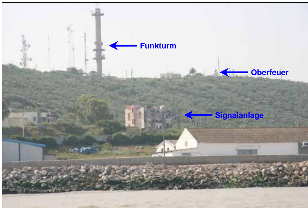
Abbildung 31: Funkturm und Hafensignalanlage in Mehdia
