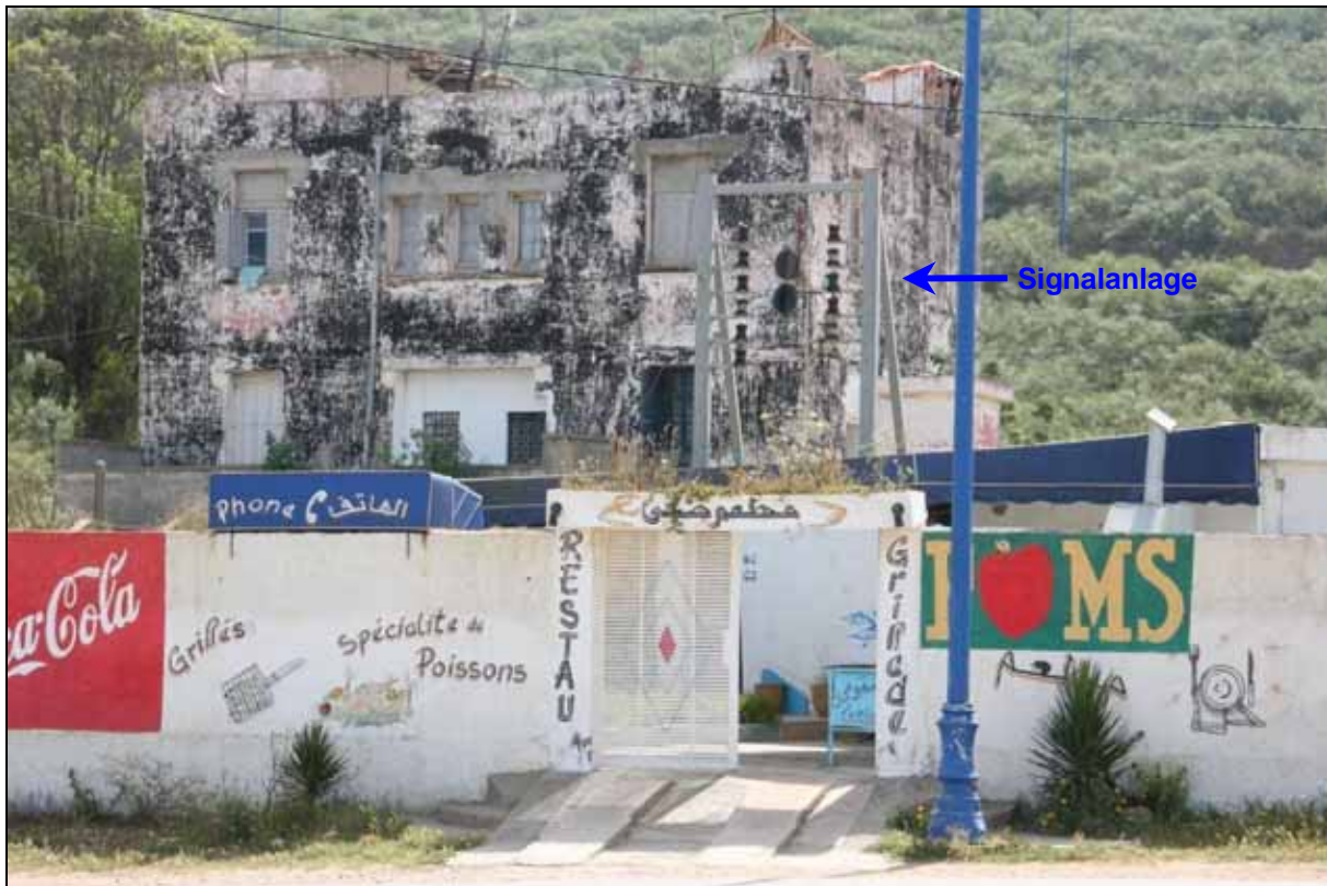
Abbildung 32: Hafensignalanlage, von Nahem aufgenommen
