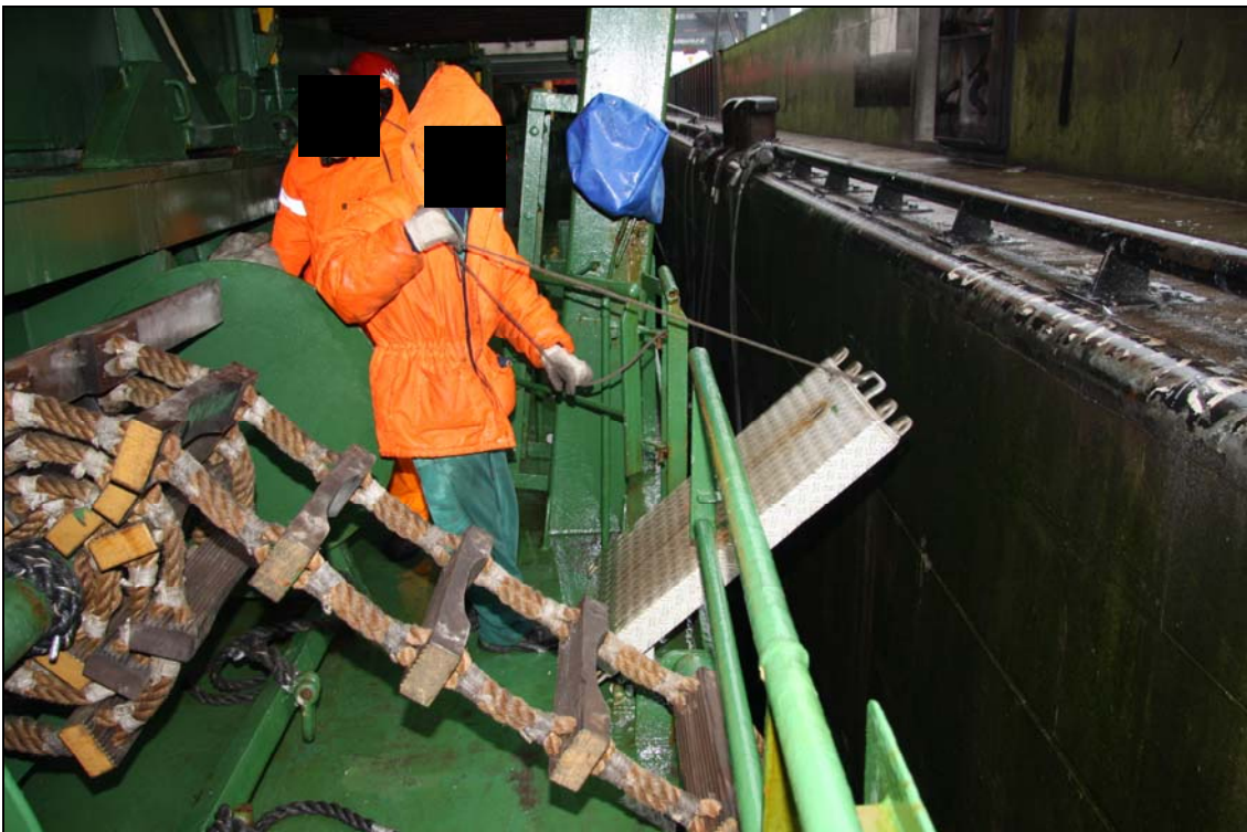
Abbildung 4: Nachgestellter Vorgang: Fieren der eingehängten Plattform an Backbord
