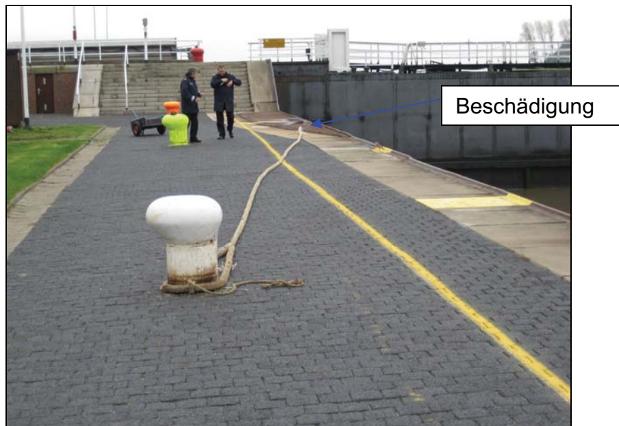
Abbildung 4: Ausgelegte, gebrochene Festmacherleine
