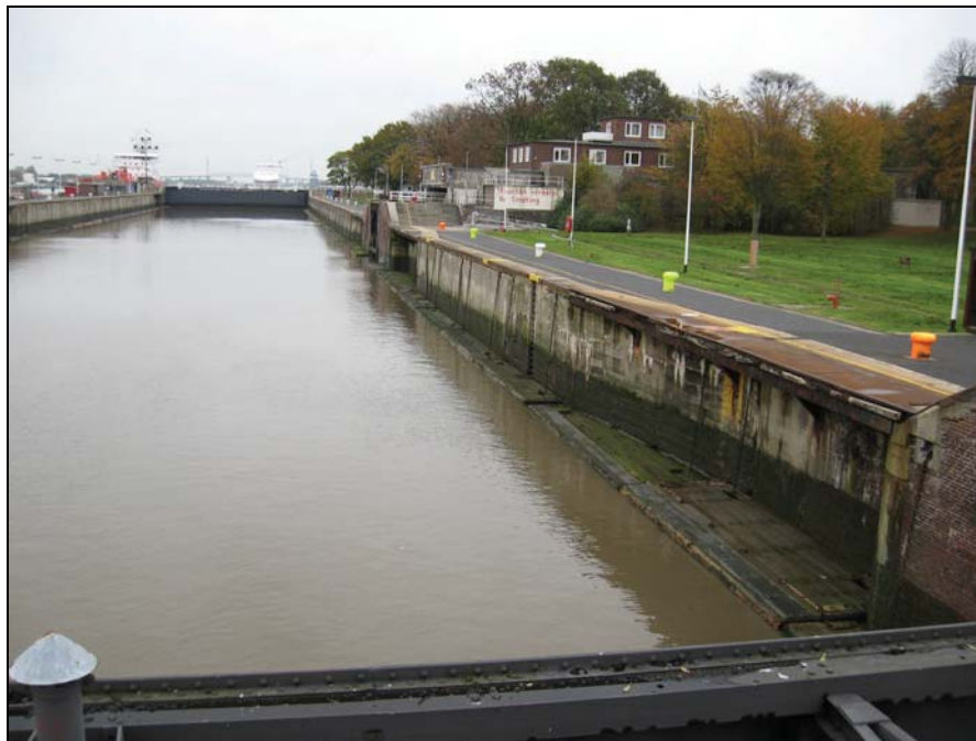
Abbildung 24: Ansicht Außenmauer mit Poller, Mittelhaupt und Notnische
