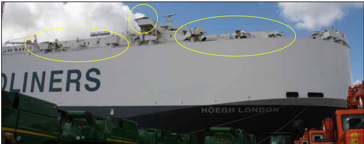
Abbildung 3: Zerstörte Lüfterköpfe und beschädigtes Sonnensiegel der Nock
