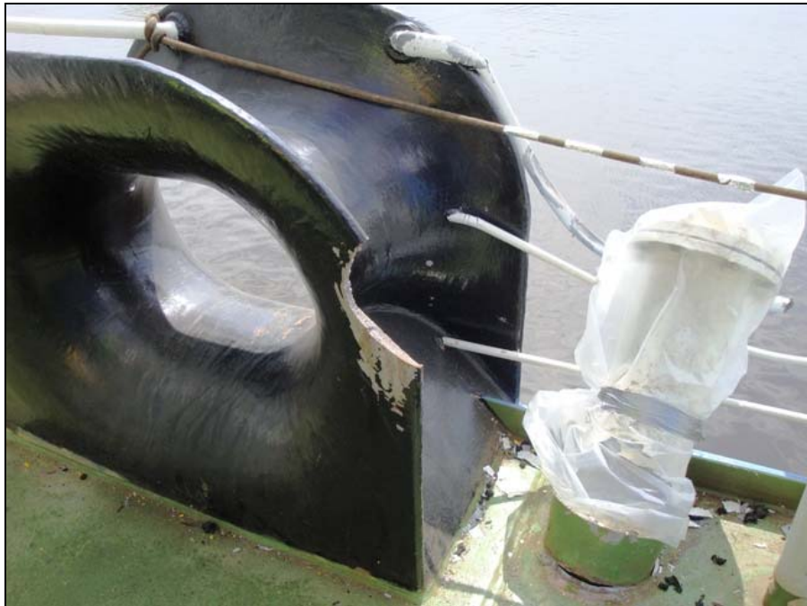
Abbildung 6: Beschädigung einer Klüse durch herumfliegendes Trümmerteil
