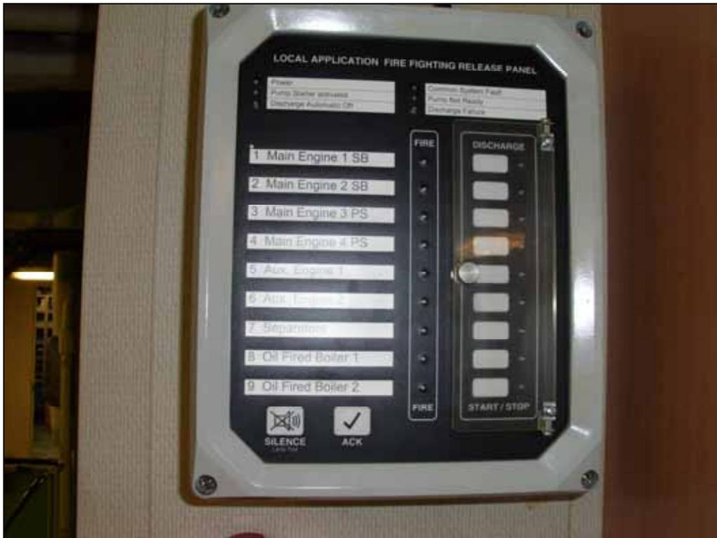
Abbildung 7: Fernauslösegerät (Remote Release Panel), befindet sich im MKR
