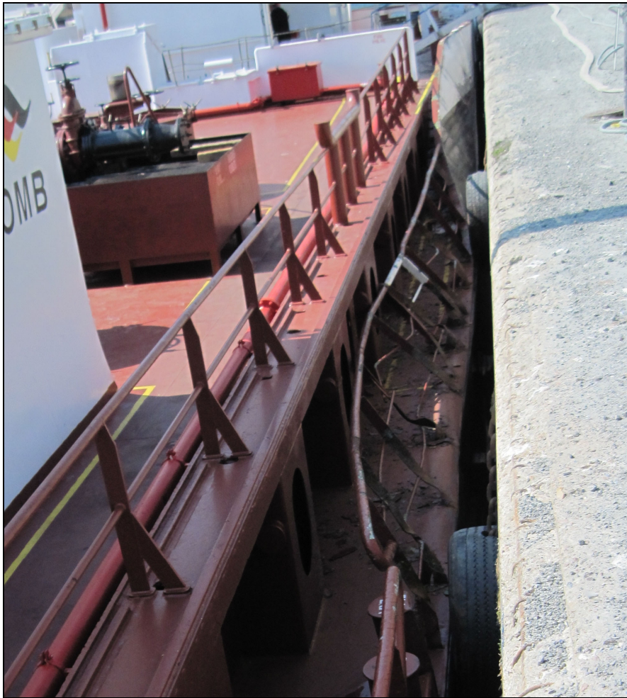
Abbildung 6: Backbordlaufgang der SÜLLBERG
