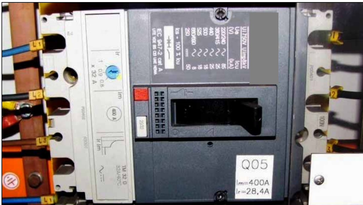
Abbildung 91: Leitungsschutzschalter, Detailaufnahme
