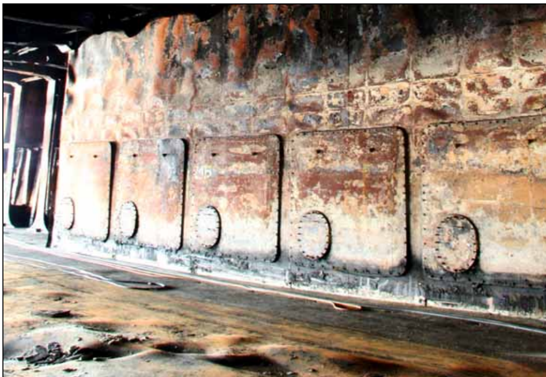
Abbildung 74: Zugänge zu den Ventilationsschächten auf Deck 6 - Backbordseite
