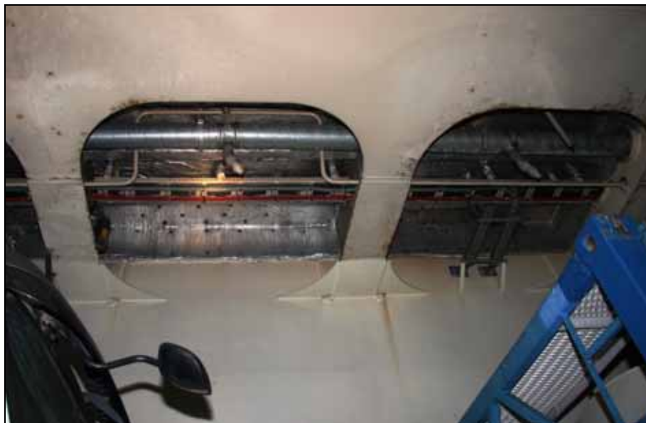
Abbildung 58: A-60 Isolierung auf Deck 2
