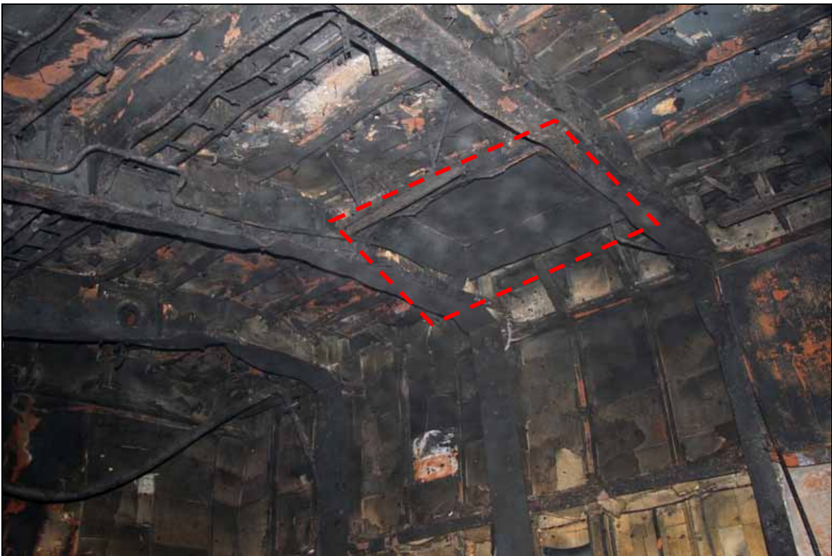
Abbildung 67: Lukenöffnung oberhalb der ersten Parkposition auf Spur 8 (Oberdeck)
