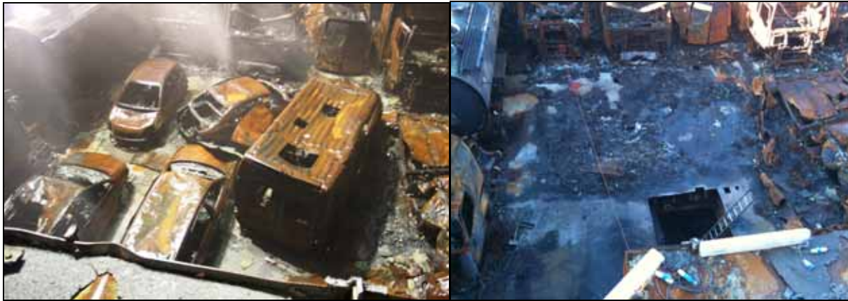
Abbildung 30: Für Löschmaßnahmen geräumter Bereich auf dem Oberdeck - vorher und nachher
