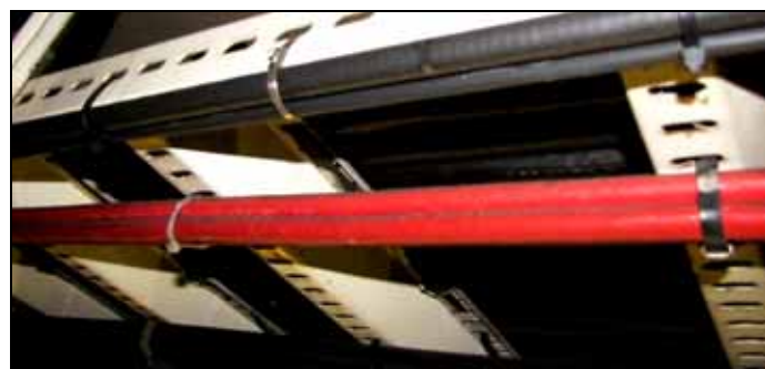
Abbildung 120: An Bord der DANA SIRENA verwendete Kabelbinder aus Metall und Kunststoff
