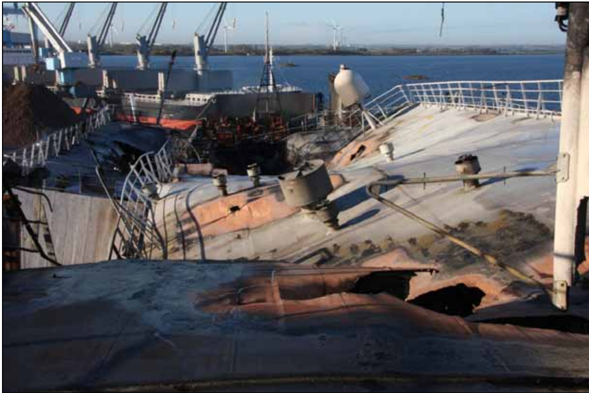
Abbildung 15: Strukturelle Beschädigung im Bereich der Aufbauten, Sicht vom Peildeck nach achtern
