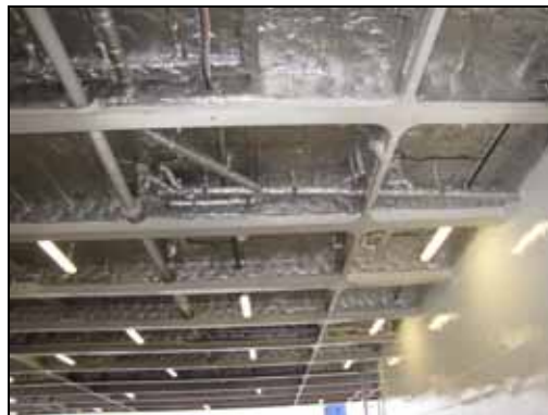
Abbildung 119: Deckenverkleidung auf dem Schwesterschiff DANA SIRENA
