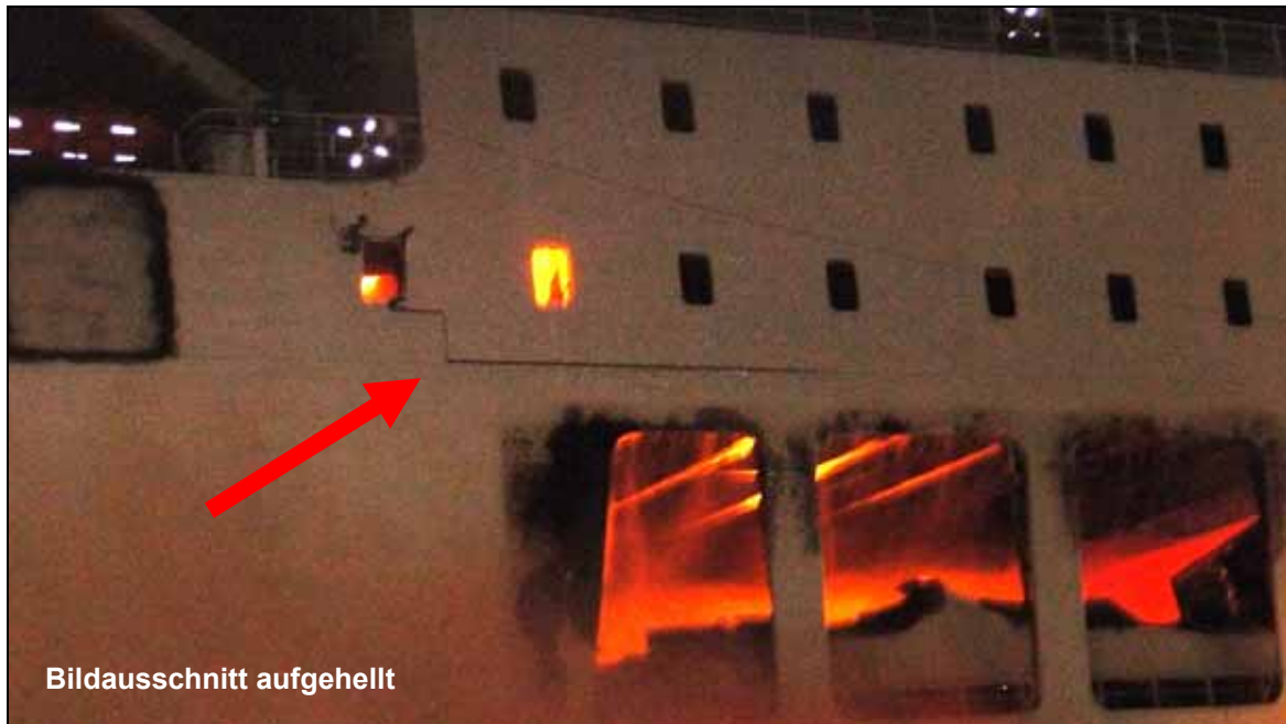
Abbildung 106: Rissbildung zwischen Deck 6 und Deck 7, aufgenommen am 9. Oktober 2010 um 06:29 Uhr
