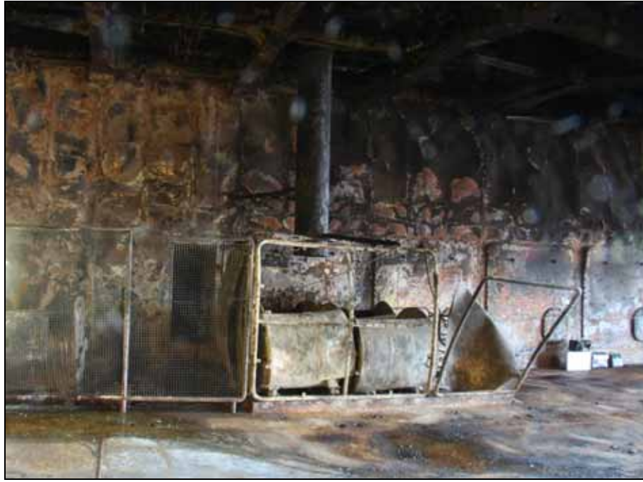
Abbildung 63: Abfallbehälter und Fallrohr auf Deck 6 nach den Räumungsarbeiten
