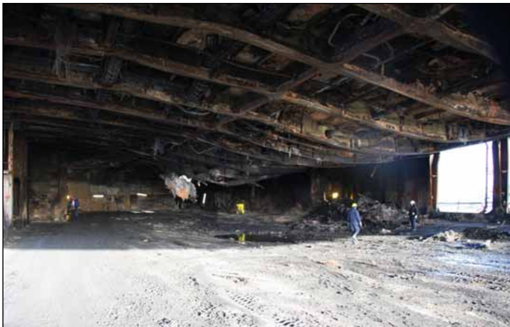
Abbildung 33: Teilgeräumtes Deck 6 mit Trümmerresten am beobachteten Brandentstehungsort
