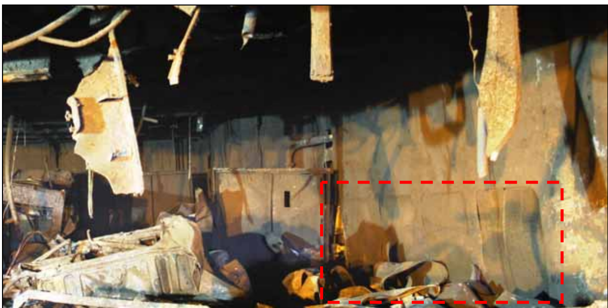
Abbildung 76: Ventilationsschächte auf Deck 4 - Steuerbordseite
