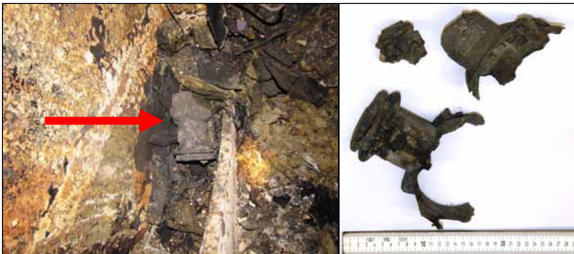
Abbildung 40: Überreste von Drehstromsteckdosen auf Höhe Spant 200, Steuerbord
