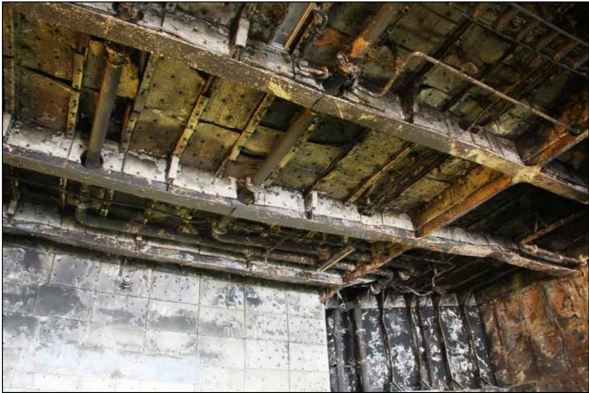
Abbildung 60: Überreste der A-60 Isolierung im überdachten Bereich auf Deck 6
