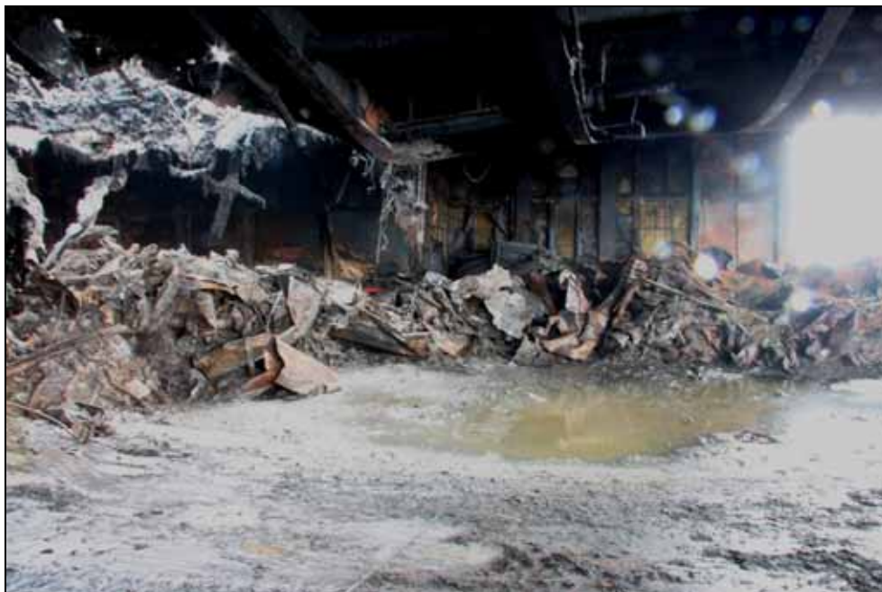
Abbildung 31: Teilgeräumtes Deck 6, Blick auf Spuren 5 bis 8 im vorderen Bereich
