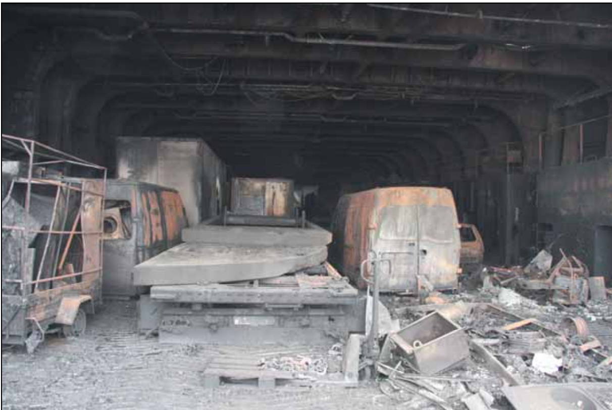
Abbildung 10: Deck 4 nach dem Brand, Blick von der Heckrampe aus nach vorn
