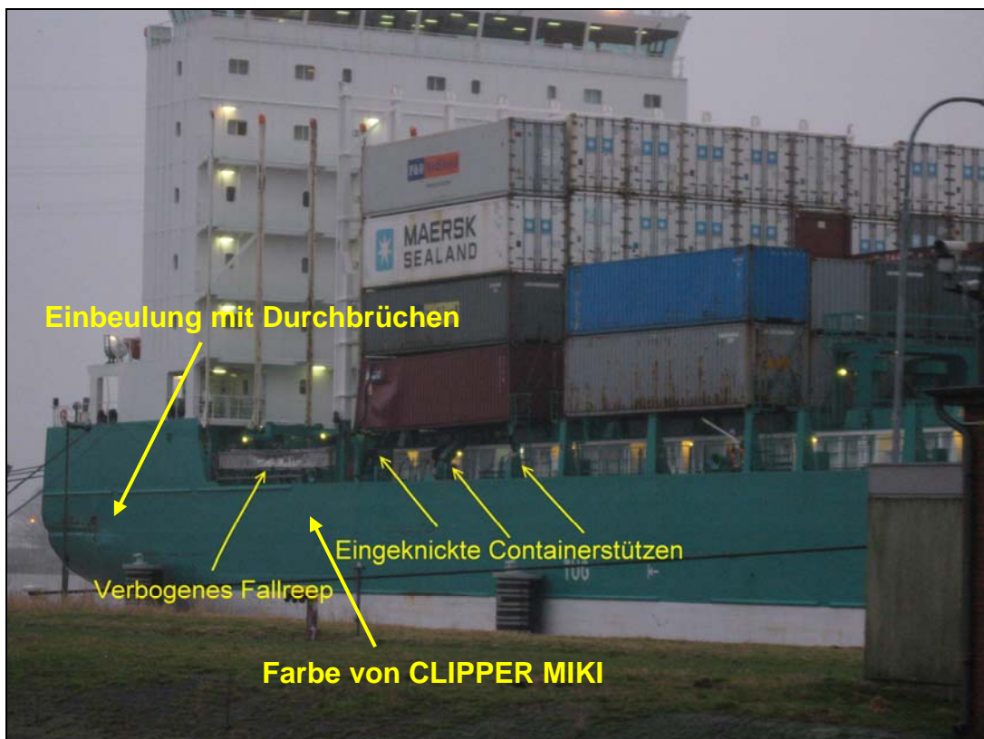
Abbildung 26: CHRISTOPHER Übersicht der Schäden achtern
