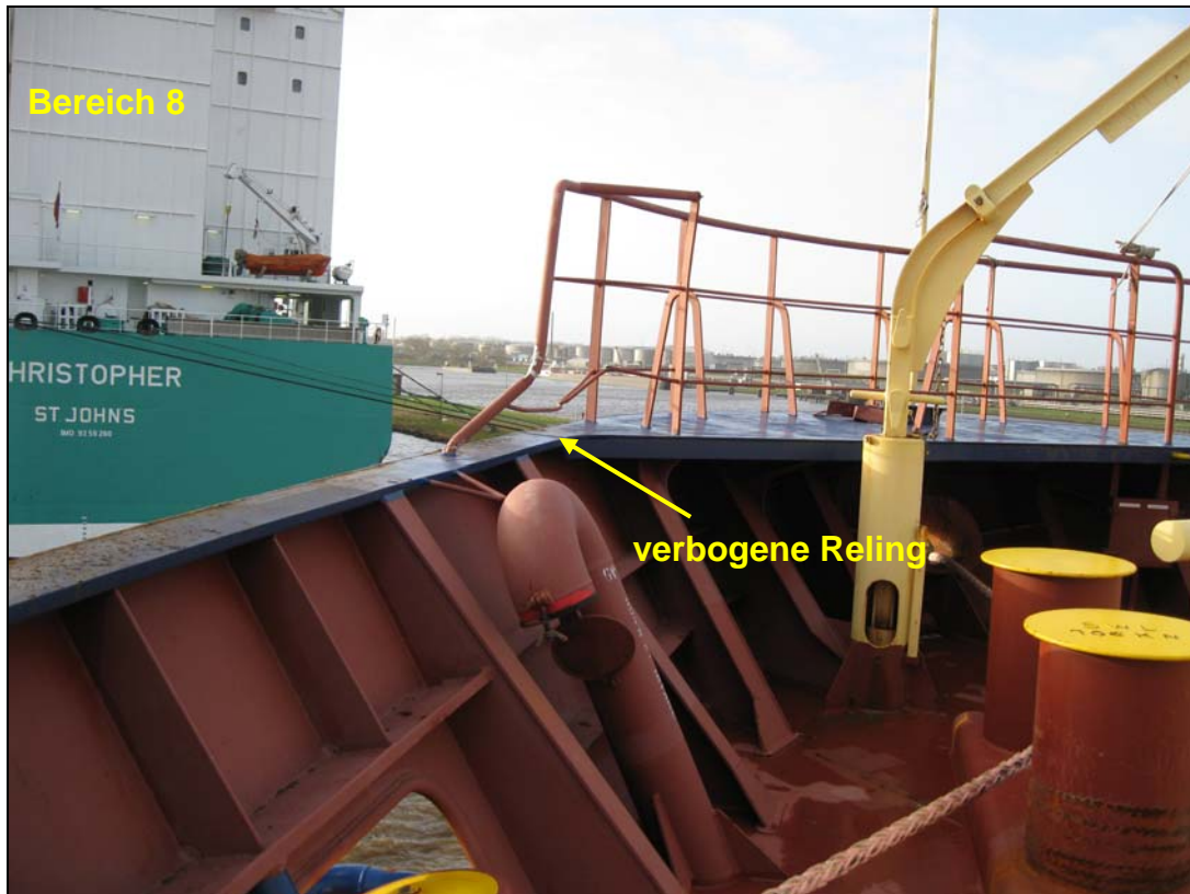
Abbildung 25: CLIPPER MIKI Schadensbereich 8
