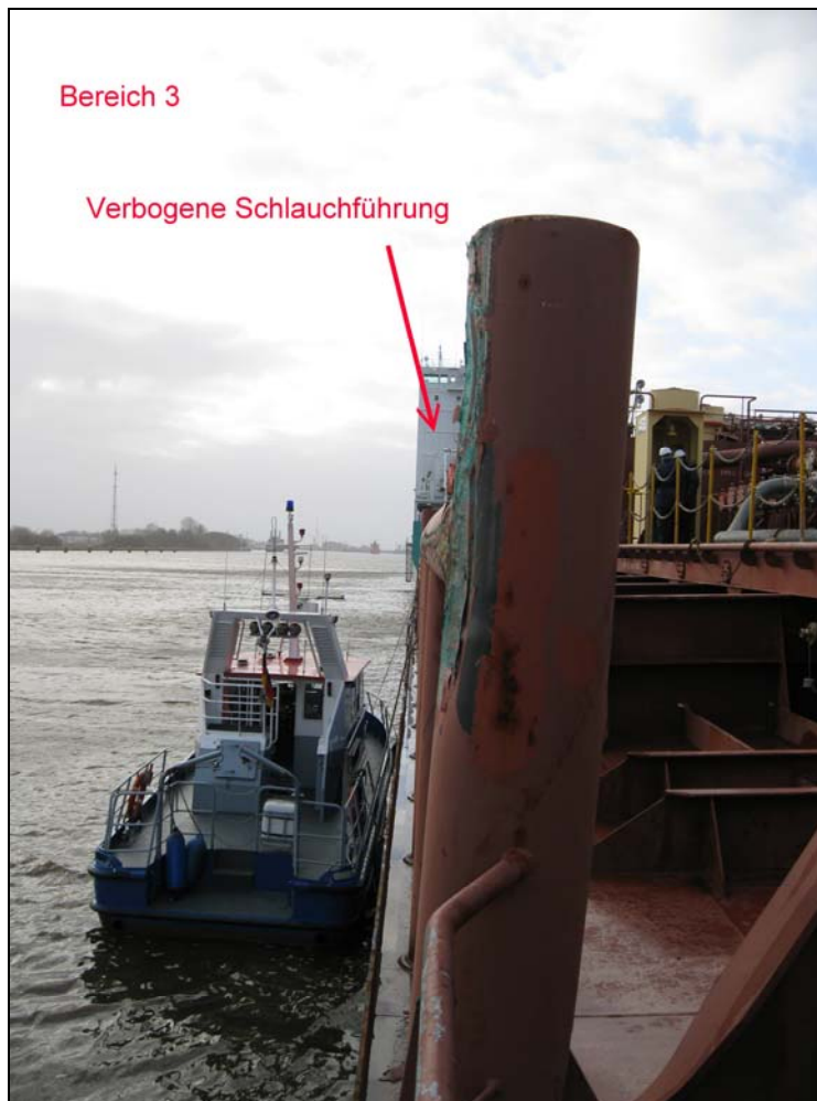
Abbildung 11: CLIPPER MIKI Schadensbereich 3
