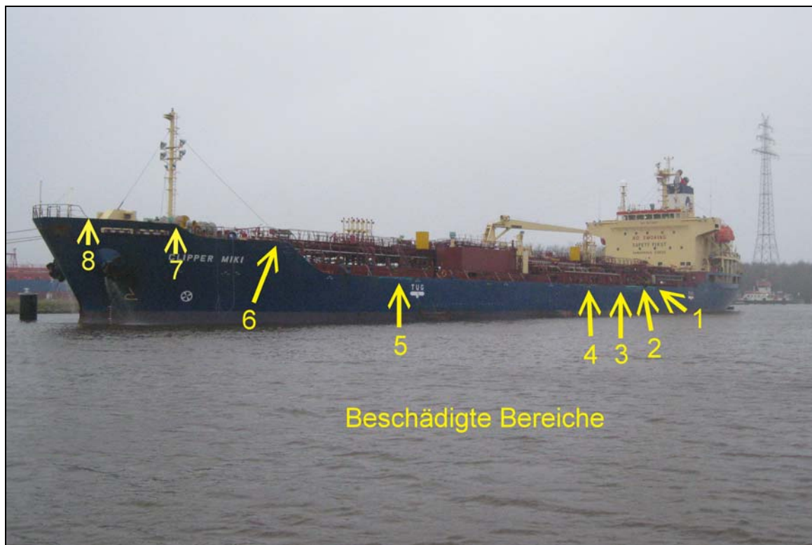
Abbildung 5: Übersicht der Schäden an CLIPPER MIKI
