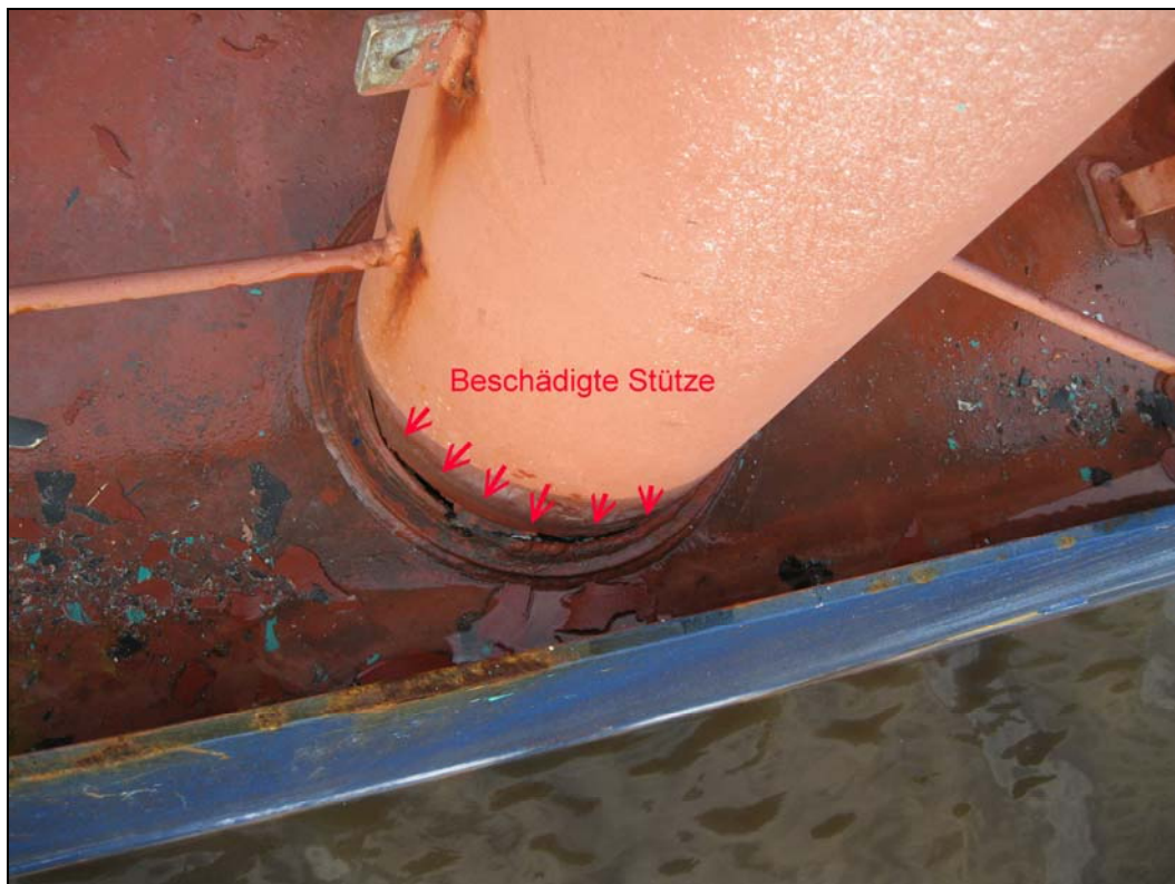
Abbildung 13: abgerissene Stütze
