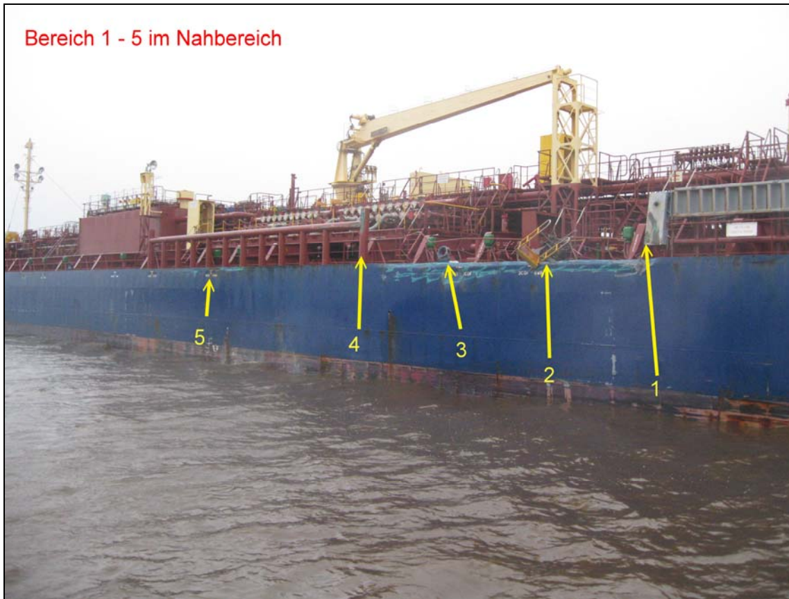
Abbildung 6: CLIPPER MIKI Schadensbereiche 1 bis 5
