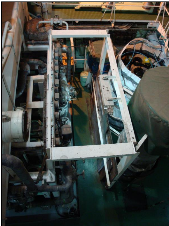
Abbildung 5: Lagerung, Sicht von oben
