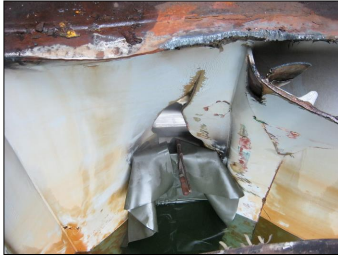
Abbildung 15: Abdichtung des Lecks in der Bordwand der URD
