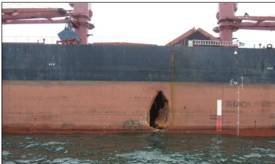
Abbildung 4: Schaden an der Seitenbordwand im Bereich von Laderaum 3
