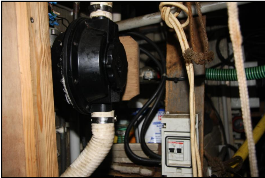
Abbildung 12: Elektrische Membranpumpe
