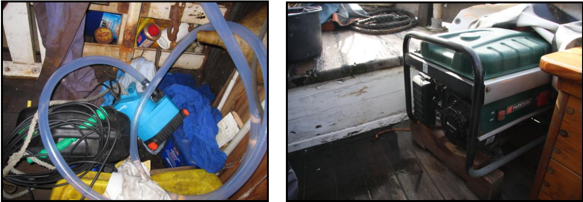
Abbildung 16: 220 V Gartenpumpe und Benzengenerator
