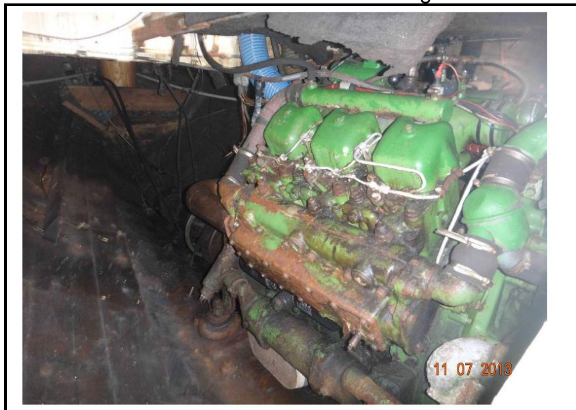
Abbildung 21: Blick auf Steuerbordseite Maschine
